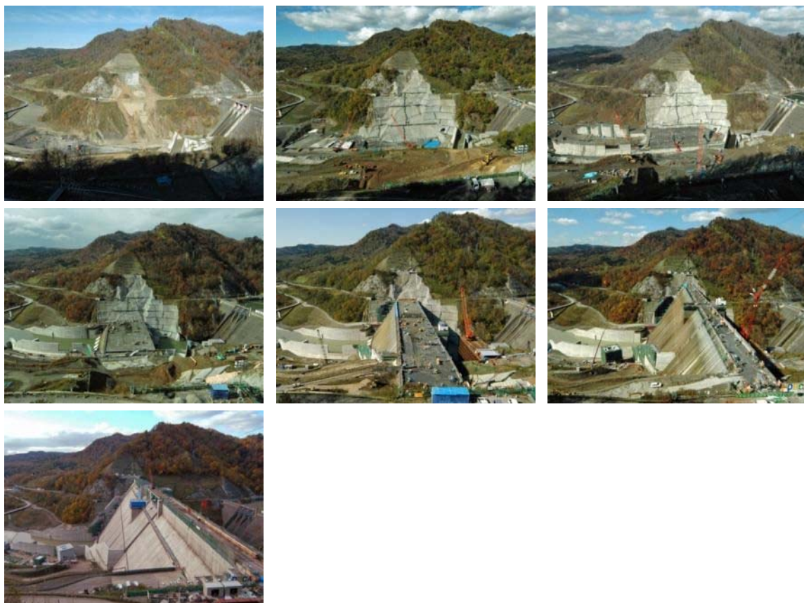
1年ごとに撮影したダム建設
