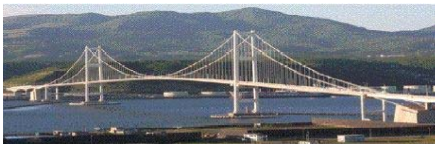
白鳥大橋全景
