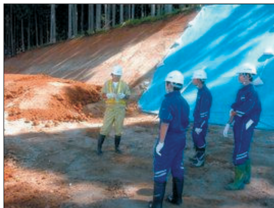
道路改築工事での盛土の学習
