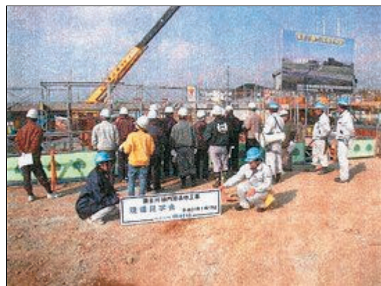
粟生川樋門築造工事現場見学会
