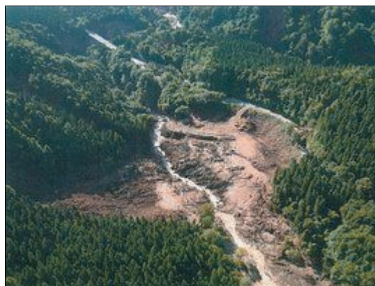
栗駒沼倉地区の地すべり
