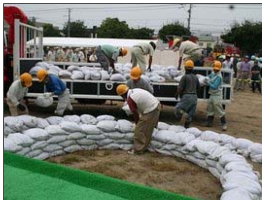
水防訓練（月の輪工法）
