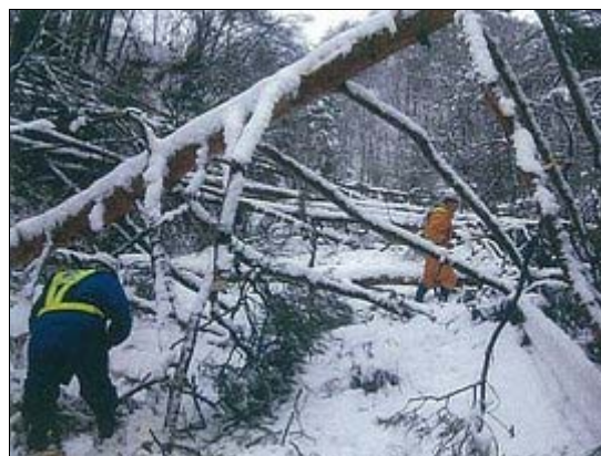
倒木の撤去作業
