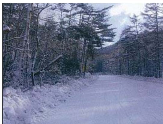
倒木撤去完了
