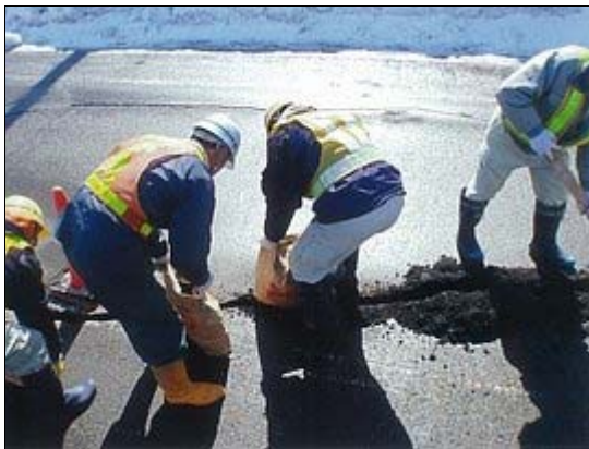
道路亀裂の修復
