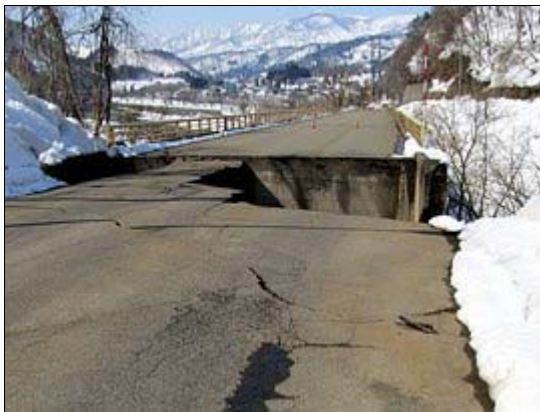
国道 117 号線の陥没被害
