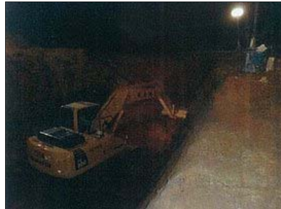
埋却溝の掘削
