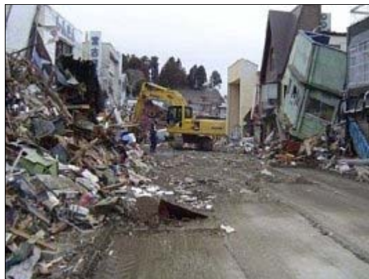
岩手県宮古市での道路啓開
