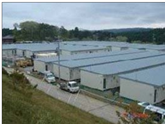
応急仮設住宅
