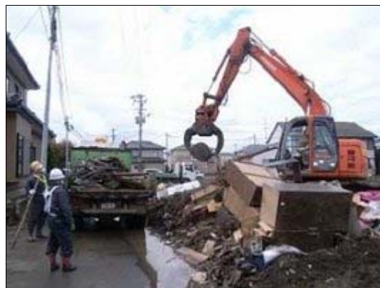
宮城県仙台市での民地のガレキ撤去作業
