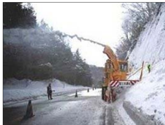
道路の除雪作業
