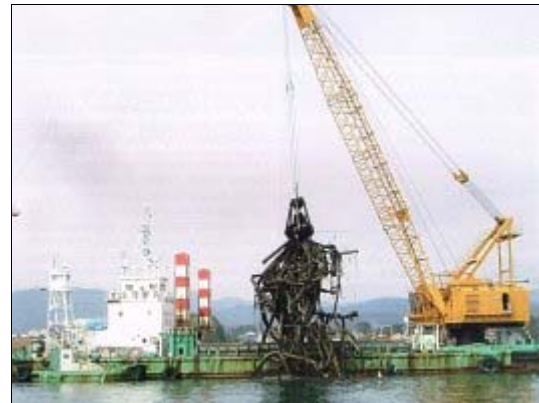
気仙沼港湾での啓開作業
