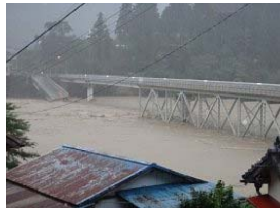
国道 168 号折立橋崩落
