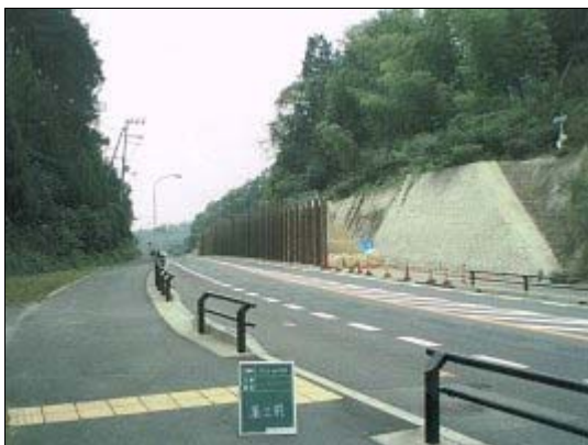
国道 9 号の復旧現場
