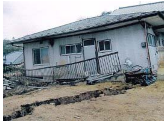
地割れによる庭の沈下
