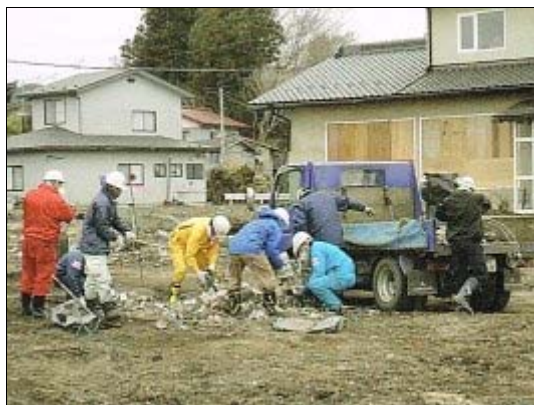
ボランティアの土砂撤収作業
