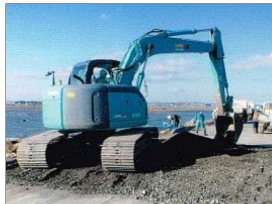
津波で分断された県道の緊急復旧
