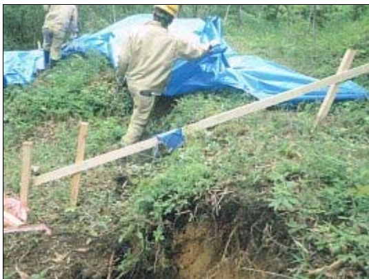
国道 9 号水原地区の法面崩落現場
