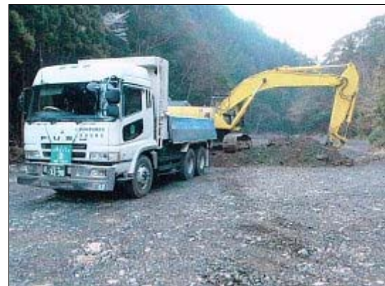
十津川村での堆積土砂掘削・積込作業
