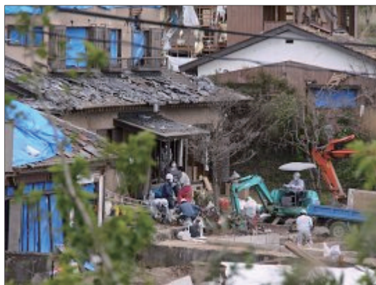
被災家屋のがれき撤去
