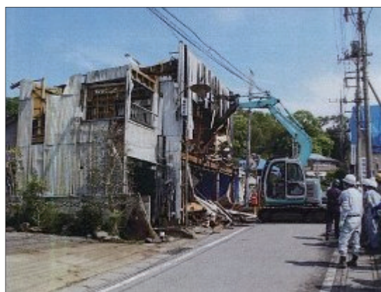
倒壊の恐れのある建物の解体
