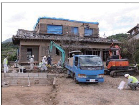
被災家屋のがれき撤去
