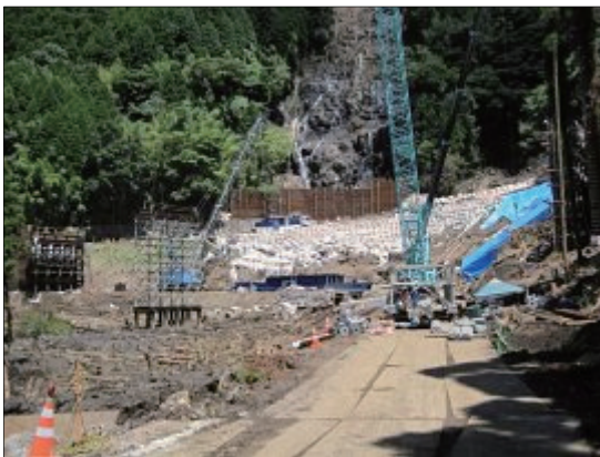
国道57号線滝室坂の復旧作業
