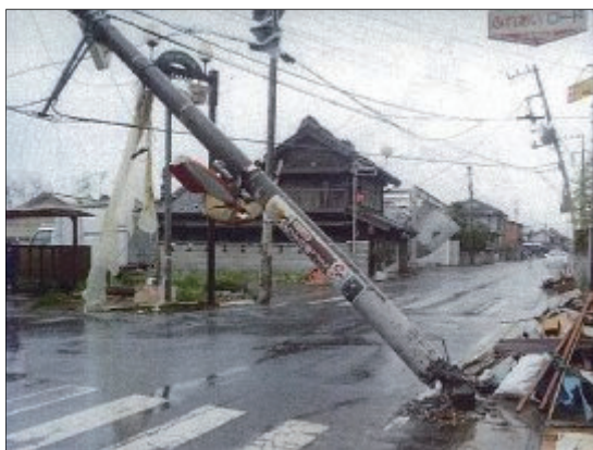
倒壊した電柱
