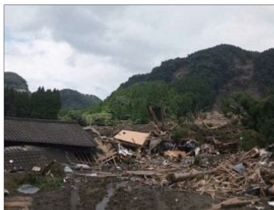
土石流による被害（坂梨地区）
