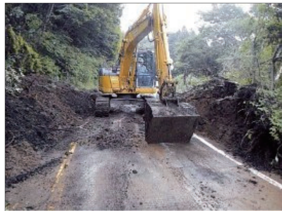
県道別府一の宮線の復旧作業
