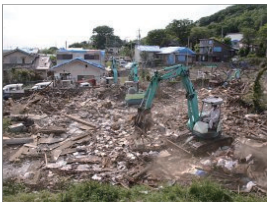
解体材の撤去
