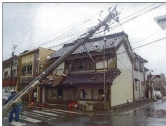
倒壊した電柱
