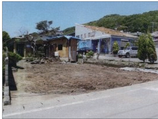
解体撤去後の整地完了
