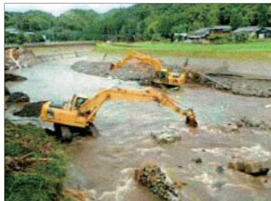
流路確保のための河床掘削
