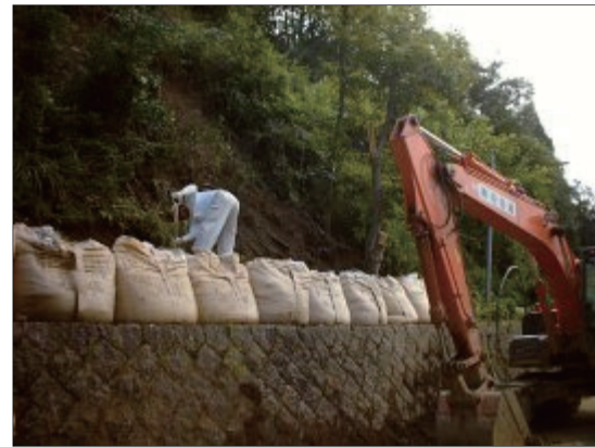
大型土のうの設置（外畑地区）
