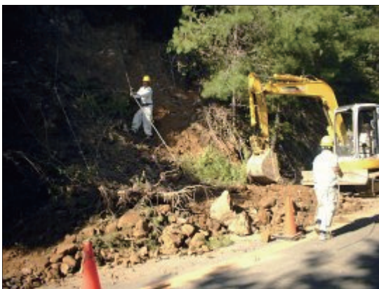
土砂の撤去（内畑地区）
