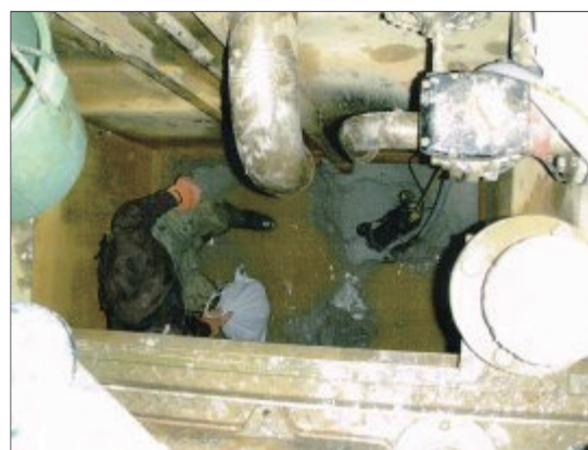
原水槽内での作業
