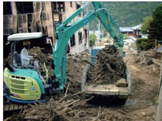
流出土砂の撤去（外畑地区）
