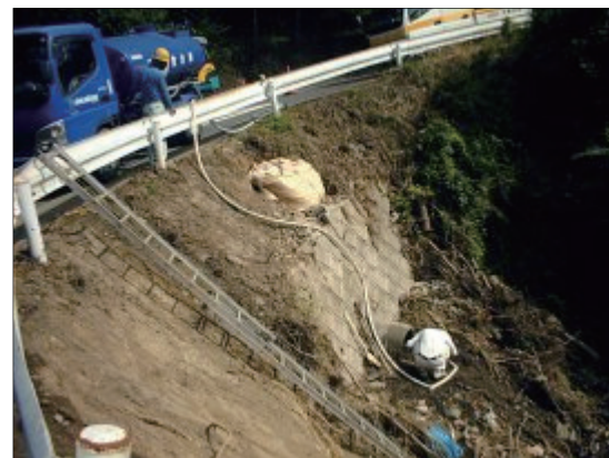
排水管の修復（内畑地区）
