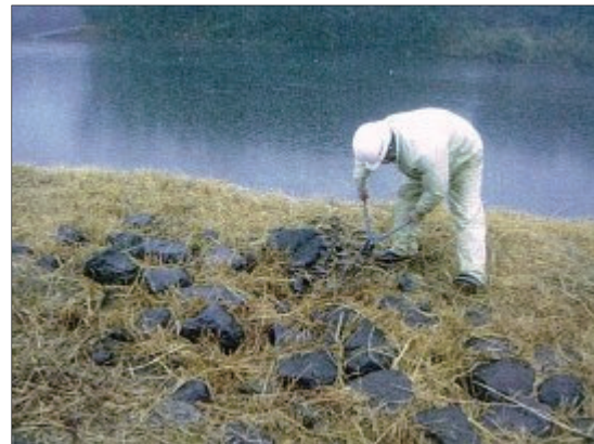
河川護岸の針金撤去
