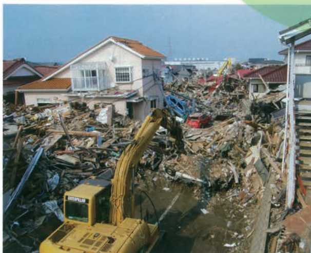
東日本大震災での瓦礫撤去作業(宮城県仙台市)
