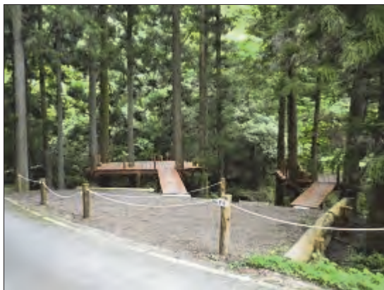
ウッドデッキサイトの増設
