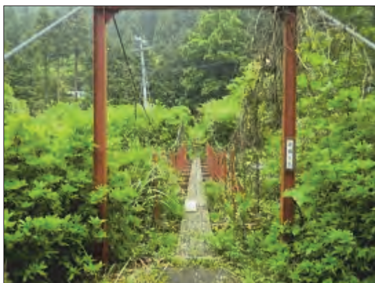
整備前の吊り橋
