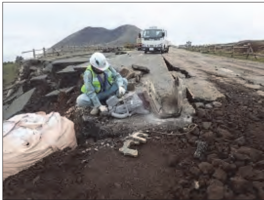
道路応急復旧（県道229号線）
