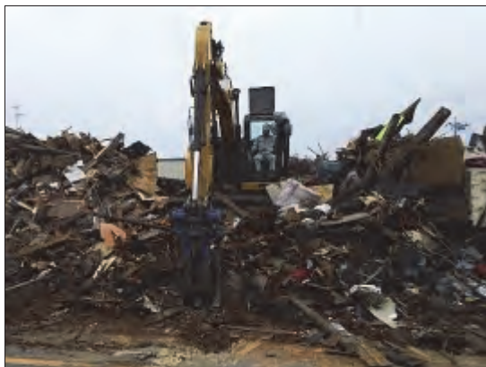
倒壊家屋の解体
