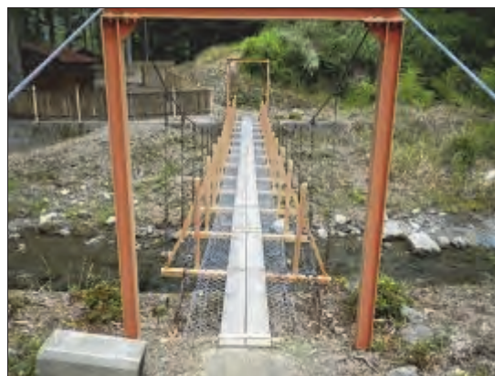
整備後の吊り橋
