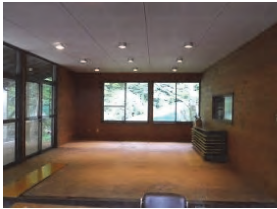
管理棟内装改修前
