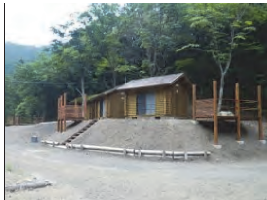
コテージのウッドデッキ設置
