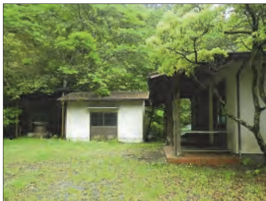
放置されたキャンプ場管理棟と水場
