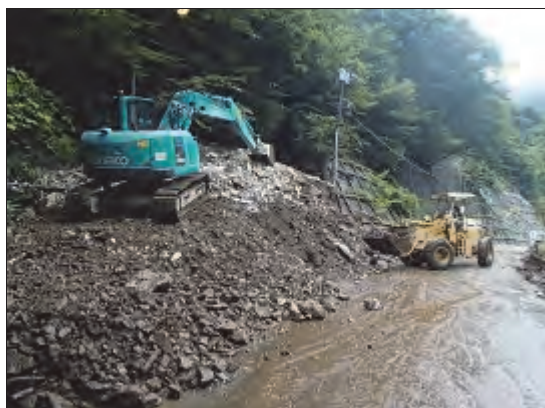
堆積土砂の撤去作業
