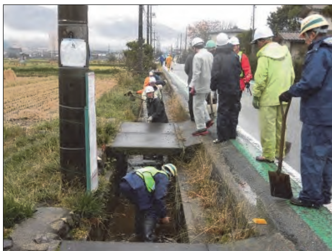
農業用水路に堆積した汚泥の撤去
