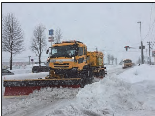
国道の除雪作業
