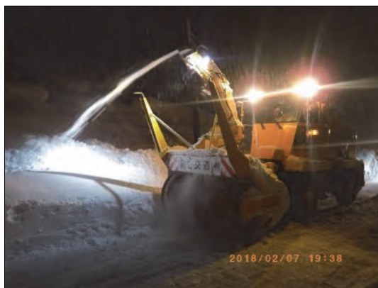
夜間作業による路肩の除排雪
