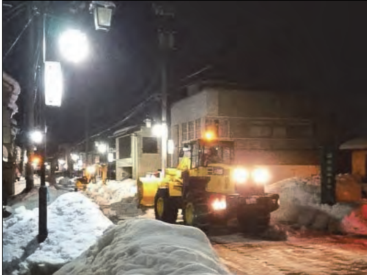
深夜の除雪作業 (あわら市)
