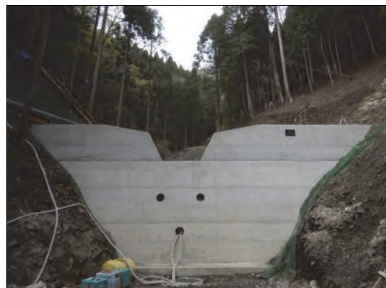
治山ダムの新設
