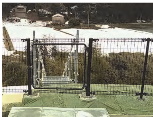
昇降路階段入口の門扉設置（礪部地区）
