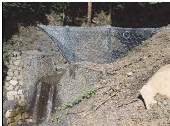
強靱ワイヤーネットの設置
