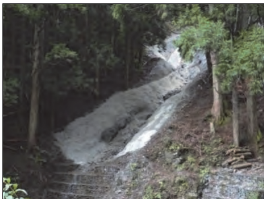
モルタル吹付による水路の確保
