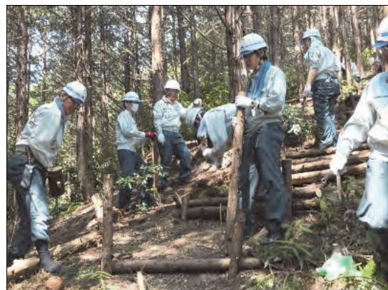
急斜面の丸太階段補修
