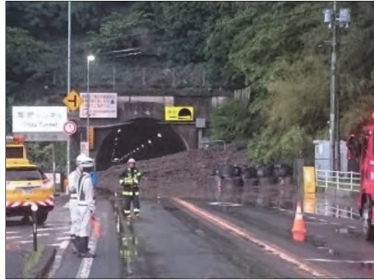
智頭トンネル付近での土砂流出
