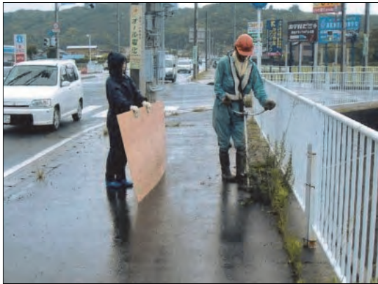
県道交差点付近の除草作業
