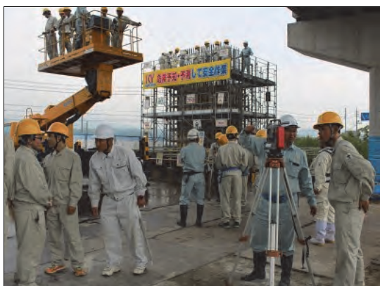
橋脚下部工事現場見学会
