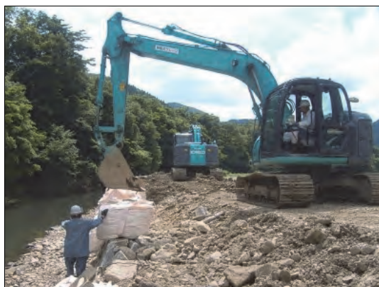
大型土のうの設置
