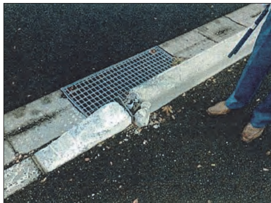
縁石の損傷発見
