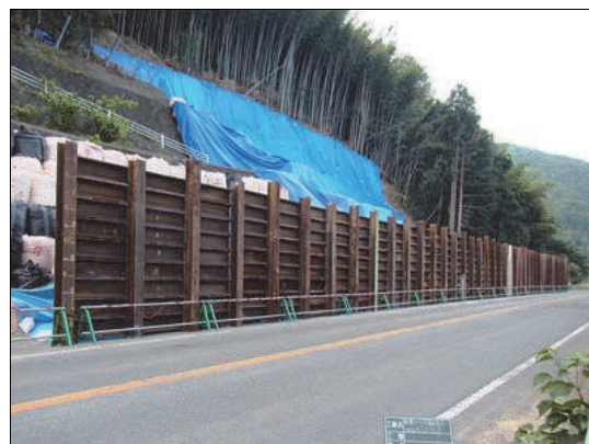
仮設防護柵完成
