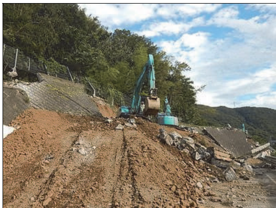
土砂撤去作業
