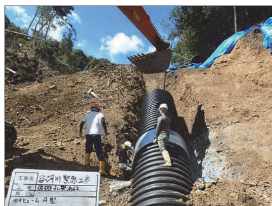
谷河川天然ダムの排水管設置
