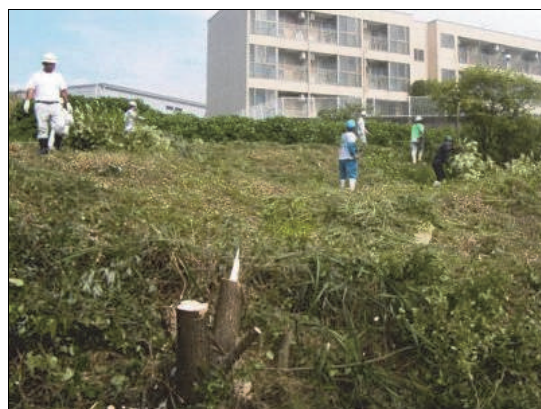
親水護岸の伐木
