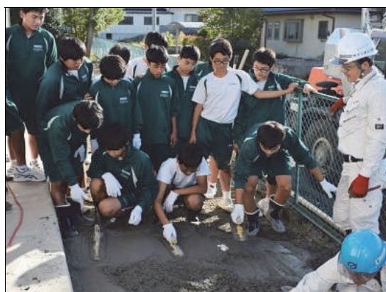
コンクリートのコテ押え体験
