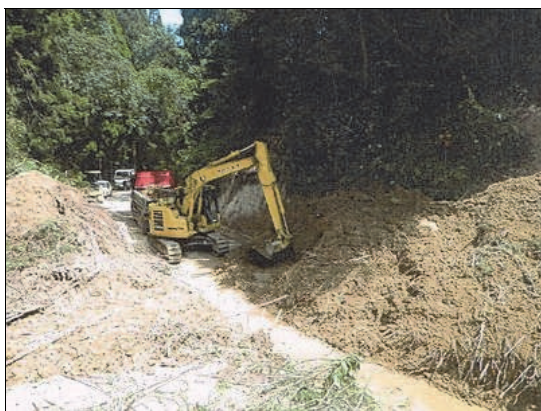
土砂撤去作業
