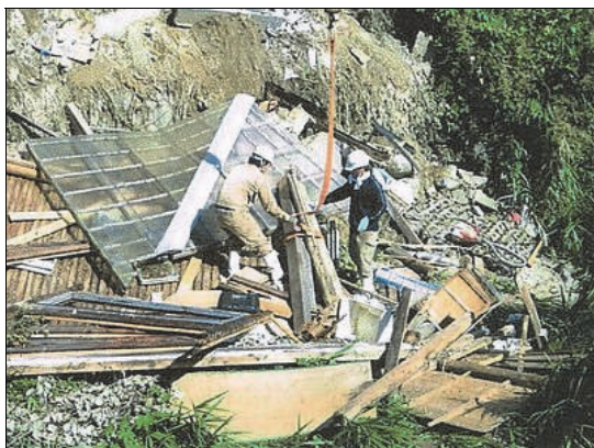
護岸崩落物の撤去
