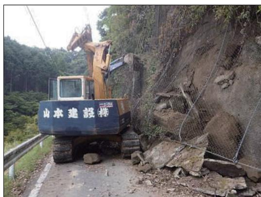
崩落法面の応急復旧（いすみ市）
