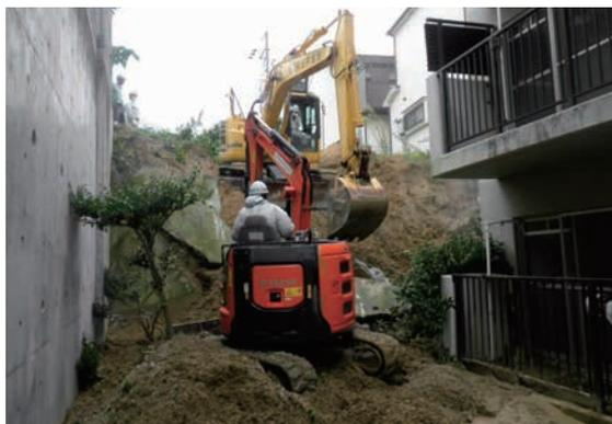
重機2台による土砂掻き出し
