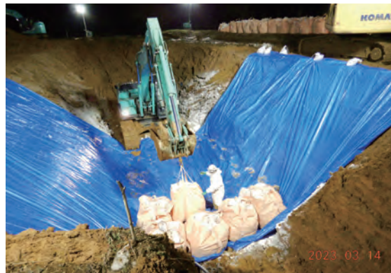
夜間の埋却作業
