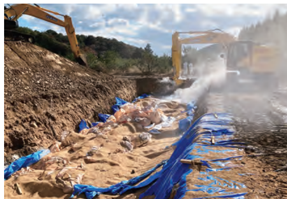
作業状況(消石灰散布)
