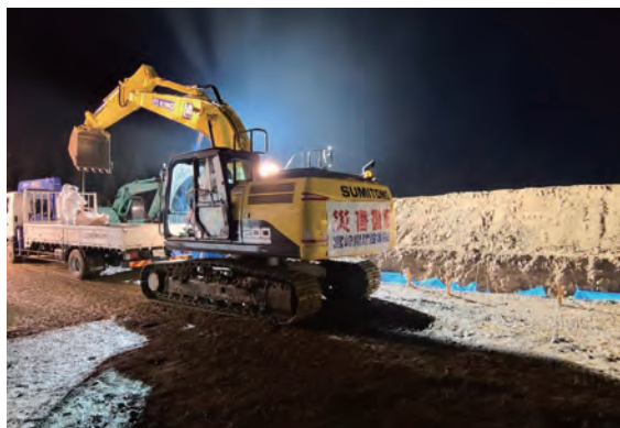
作業状況(埋却)
