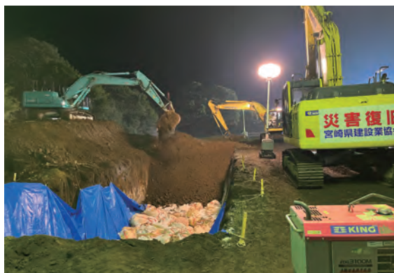
作業状況(新富町)
