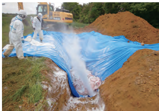
殺処分した鶏埋却作業(石灰散布)
