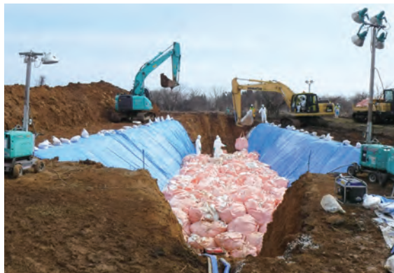
殺処分した鶏の埋却作業
