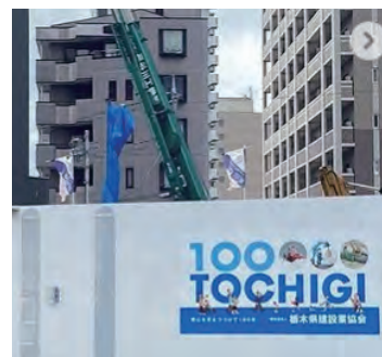
施工現場に設置しPR
