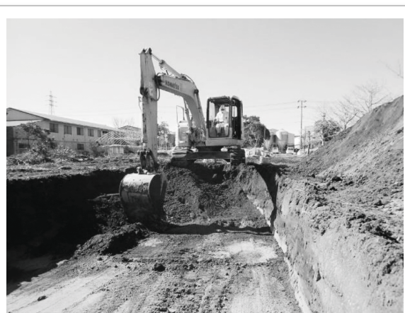
鳥インフルエンザの埋却溝掘削作業 (千葉県建設業協会)
