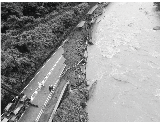
令和2年7月豪雨 国道41号線の崩落の様子 (岐阜県建設業協会)
