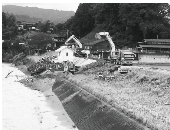
令和2年7月豪雨 球磨川堤防の復旧（熊本県建設業協会）
