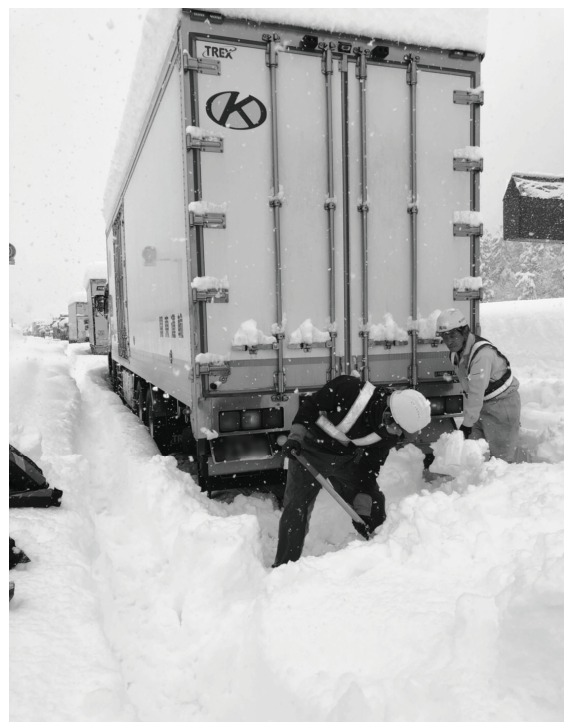
関越自動車道の除雪作業 (新潟県建設業協会)
