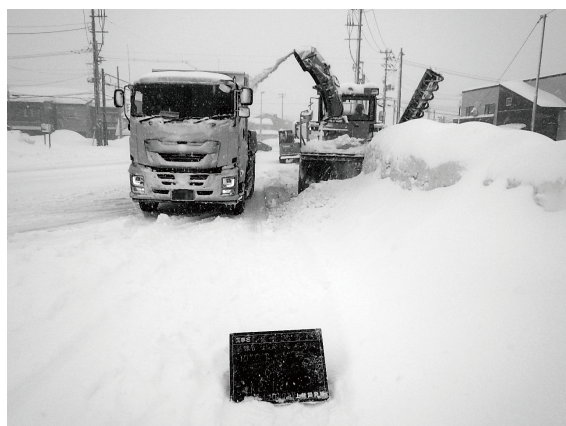
上越市内の除雪作業 (新潟県建設業協会)
