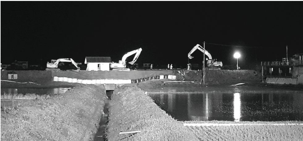
令和2年7月豪雨 昼夜を問わず行われた球磨川堤防の復旧 (熊本県建設業協会)
