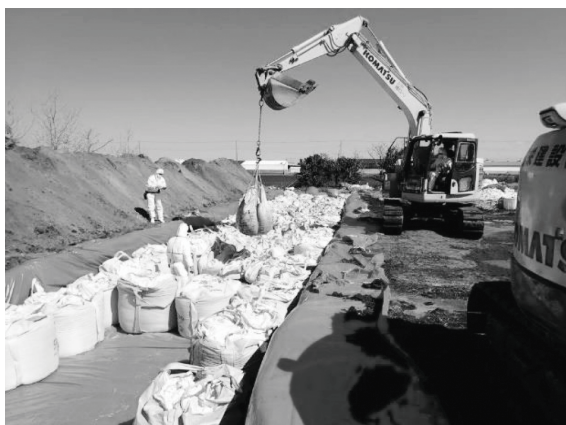
鳥インフルエンザの埋却作業 (千葉県建設業協会)
