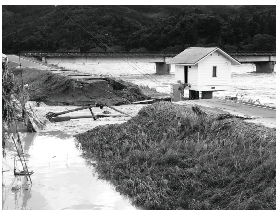
令和2年7月豪雨 球磨川堤防決壊箇所の様子（熊本県建設業協会）
