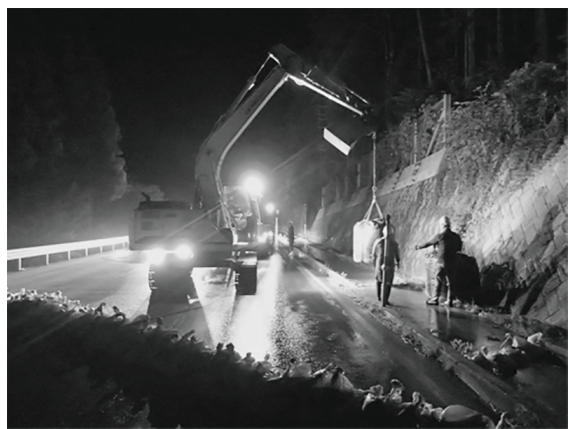
令和2年7月豪雨 夜間も行われた道路の応急復旧 (岐阜県建設業協会)
