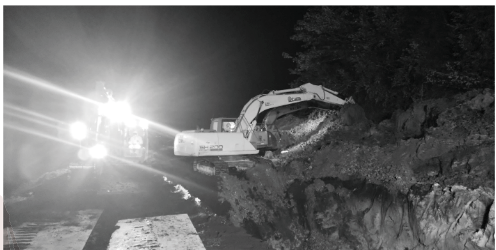
昼夜を問わず行われた豚熱の埋却溝掘削作業 (群馬県建設業協会)
