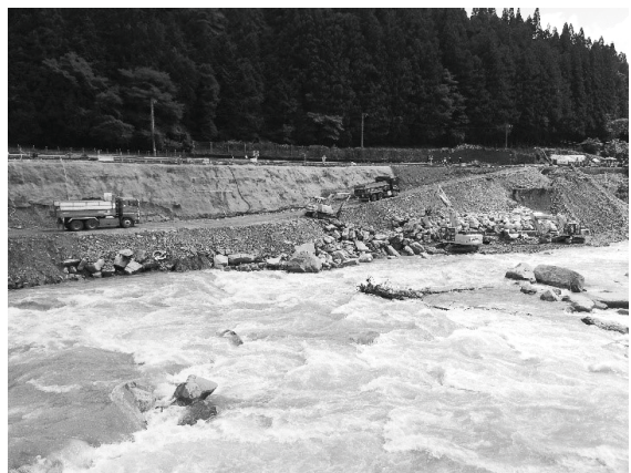
令和2年7月豪雨 濁流そばで行われた国道41号線の復旧 (岐阜県建設業協会)
