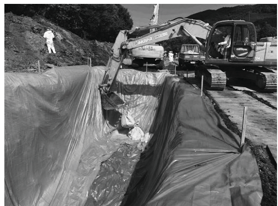
豚熱の埋却作業 (群馬県建設業協会)
