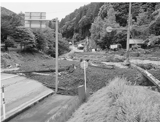
令和2年7月豪雨 道路の応急復旧 (岐阜県建設業協会)
