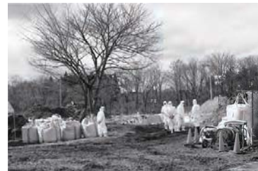
▼第2埋却地現場状況
