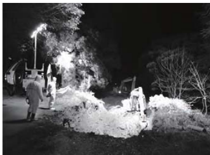
埋却地の掘削
