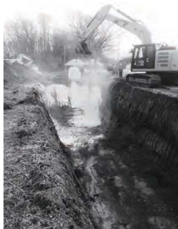
◀第2埋却地石灰投入
