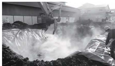
掘削した穴にブルーシートを敷設し、ペールを消毒しながら埋却処分していく様子
