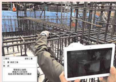
Webカメラを利用した遠隔検査
