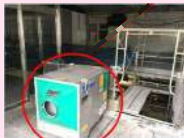
集塵機を設置し室内の換気を実施
