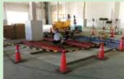
工事エリアの区画を設定して作業
