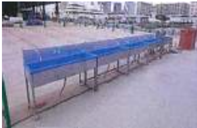
現場の手洗い場所の増設
