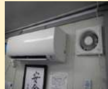
扇風機や換気扇とエアコンを併用
