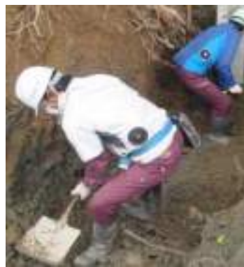
空調機能付きの作業服を活用
