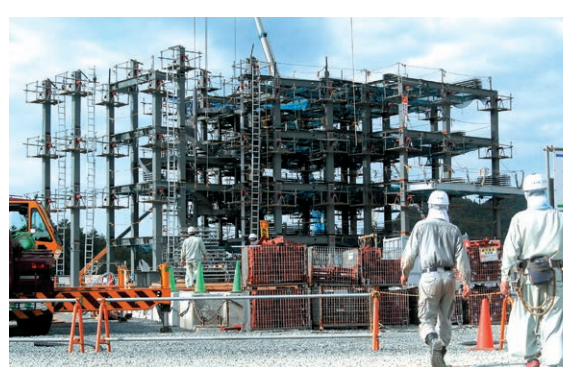
公共施設の工事現場
