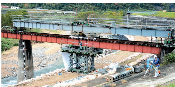
JR三江線井原川橋梁の復旧工事
