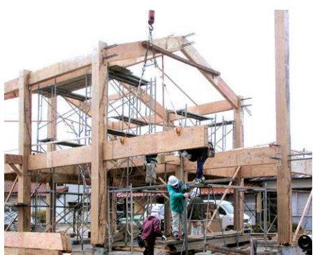
一般住宅の建設作業現場
