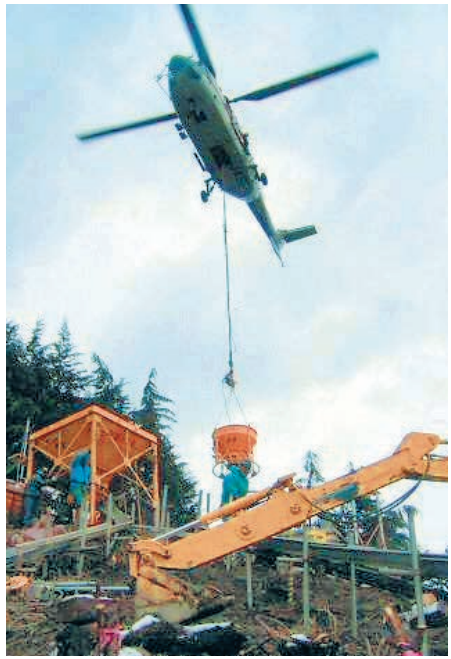
建設資材や建設機械の山中への運搬にはヘリコプターも使う
