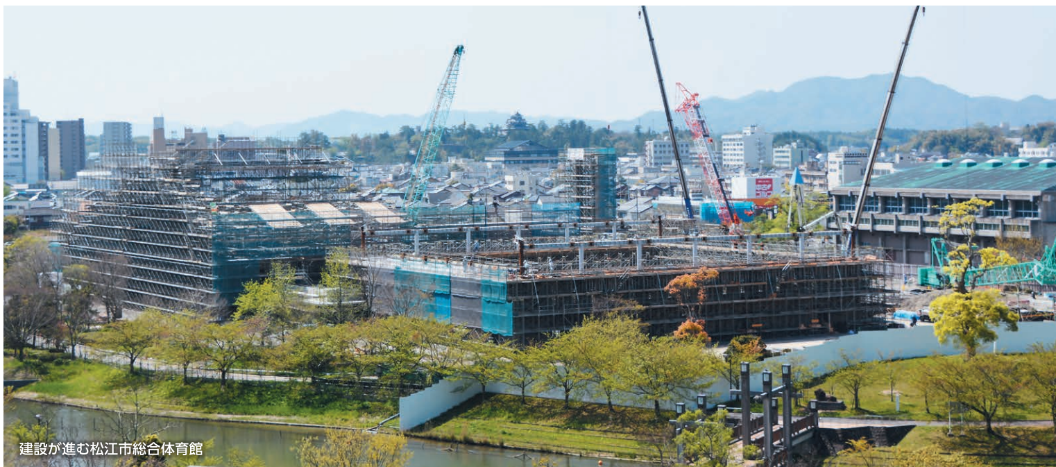
建設が進む松江市総合体育館
