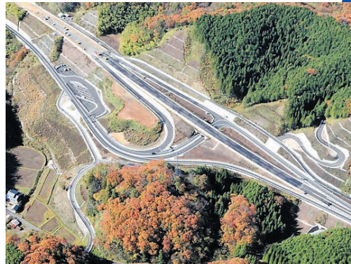
中国横断自動車道 尾道松江線吉田掛合IC付近 (国土交通省松江国道事務所提供)
