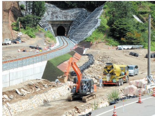
豪雨災害の復旧工事現場
