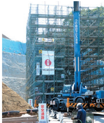
橋の上部構造の両端を支える基礎となる「橋台」を施工する様子
