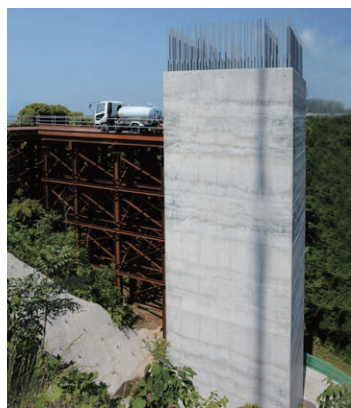
高速道路の土台の一部となる橋脚＝出雲市多伎町
