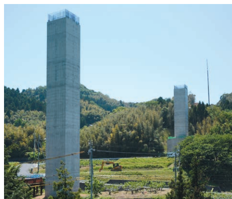
山あいを数多くの橋梁やトンネルでつなぎ、山陰自動車道が整備されていく
