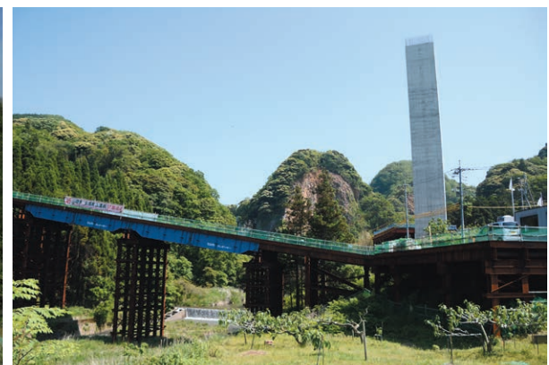
整備が進む多伎朝山道路＝出雲市多伎町
