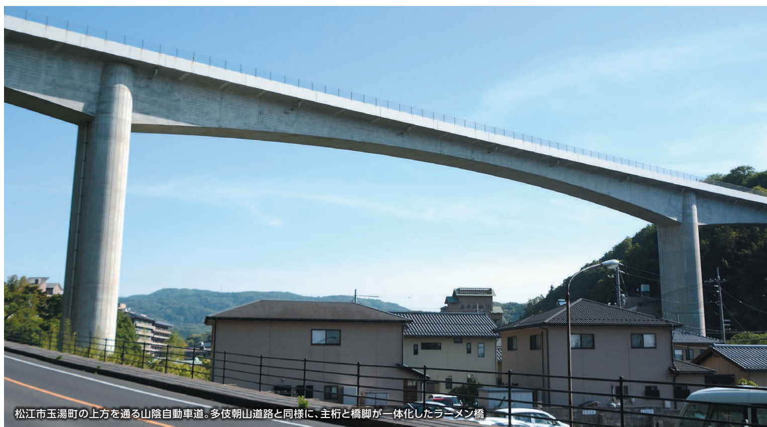
松江市玉湯町の上方を通る山陰自動車道。多伎朝山道路と同様に、主桁と橋脚が一体化したラーメン橋
