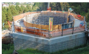
大口径深礎杭の施工現場。地中深くに穴をあけ、コンクリートで基礎を固める
