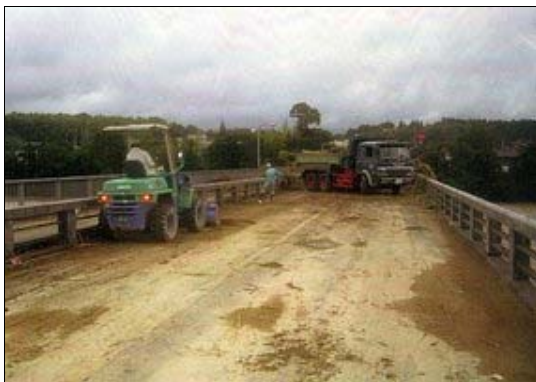
橋上の流木除去
