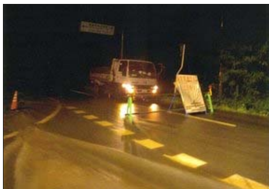
通行止標識の設置
