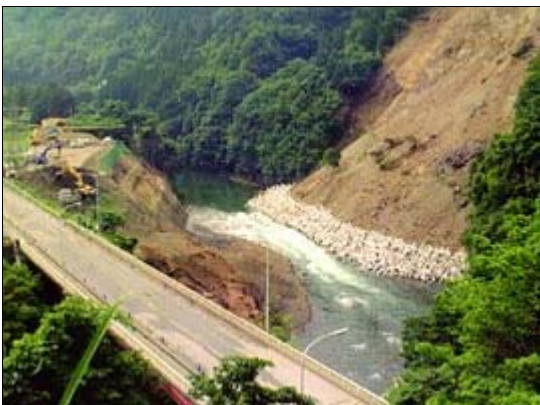
応急復旧完了
