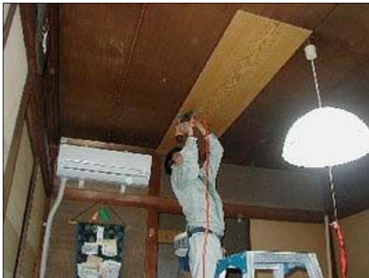
天井板の補修
