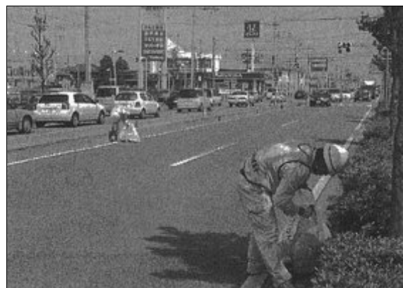
道路上のゴミ回収作業
