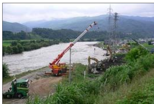
天竜川の応急復旧工事
