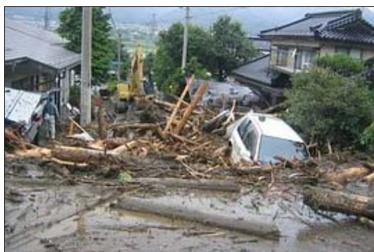
土石流災害の復旧 (箕輪町)
