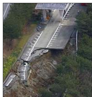
能登有料道路の崩落
