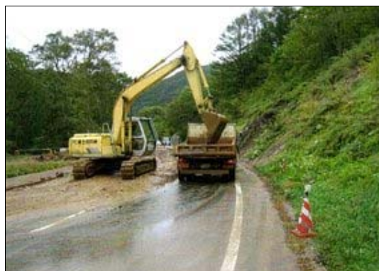
土砂の撤去作業
