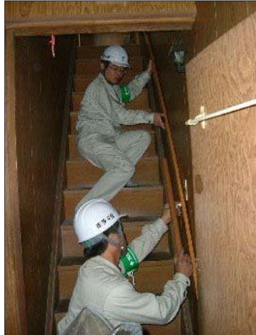
階段手すりの取付け
