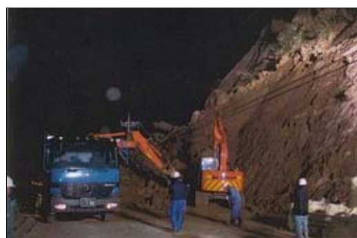
国道 249 号線応急復旧工事の夜間作業
