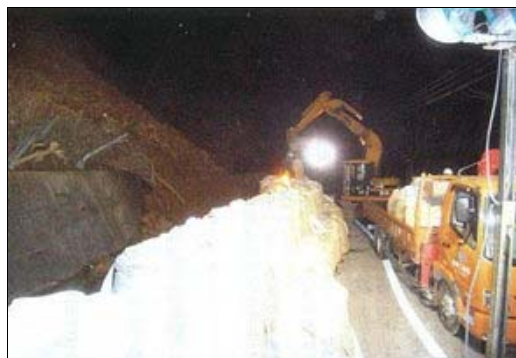
応急復旧工事の夜間作業
