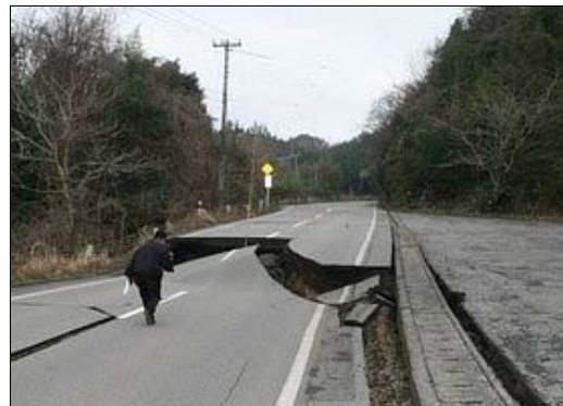
国道 249 号線の陥没
