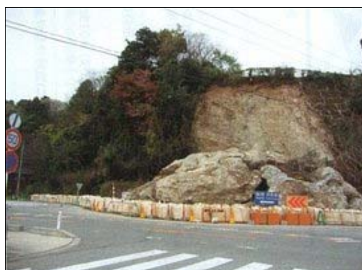
がけ崩れ箇所の応急措置
