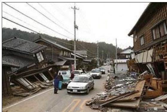
家屋の倒壊（輪島市）
