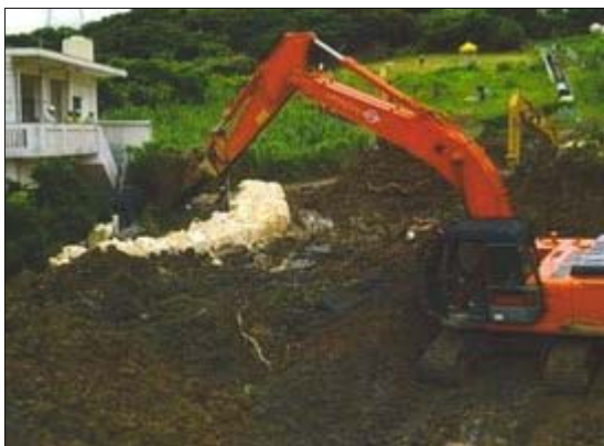
土嚢設置による土砂流入防止対策
