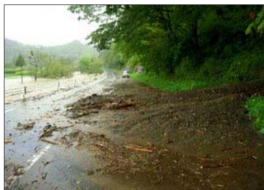
土砂の流出 (葛巻町)
