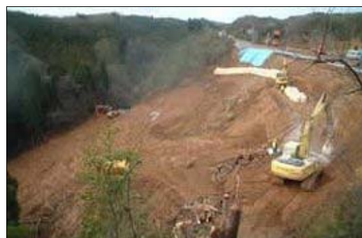
能登有料道路の応急復旧工事
