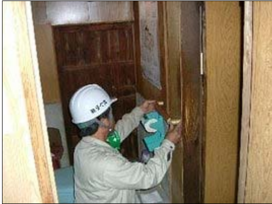
トイレ手すりの取付け
