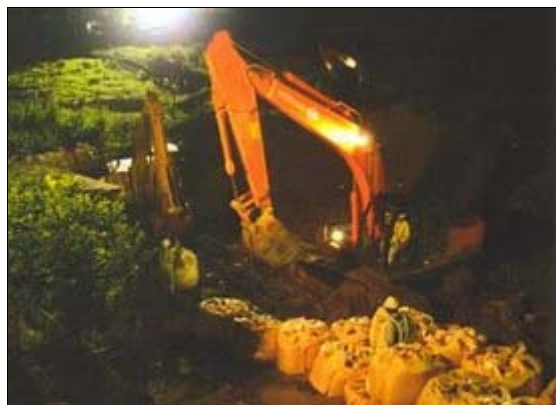
土嚢設置による土砂流入防止対策
