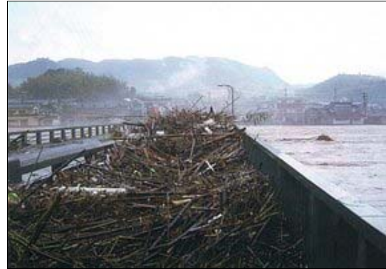
豪雨による河川流木の滞留
