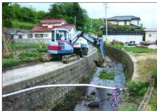
平呂木沢川の堆積土砂撤去
