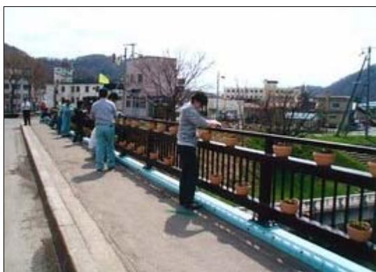
プランターの設置
