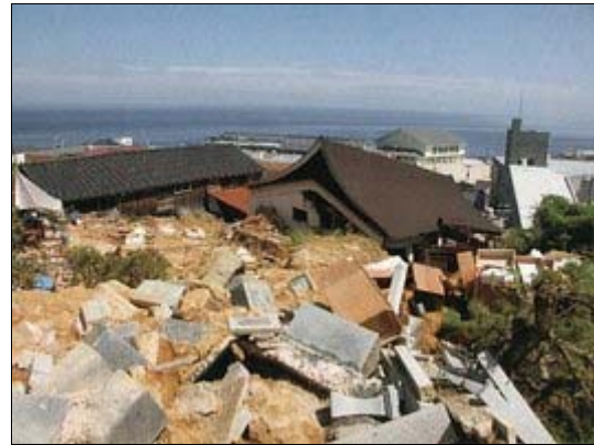
土砂崩れ災害
