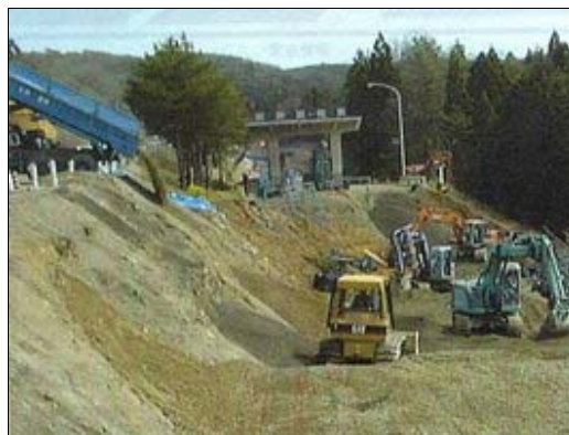
能登有料道路の復旧工事
