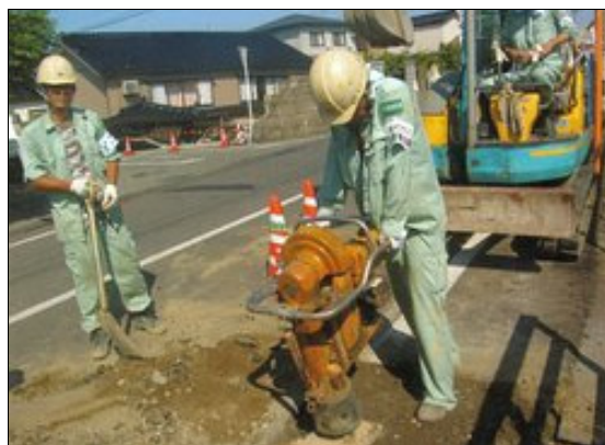
ガス応急復旧作業
