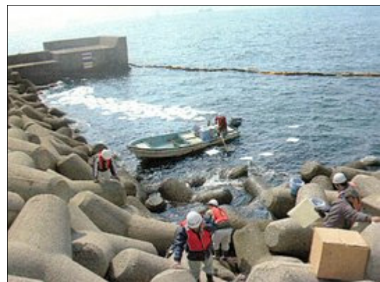
回収油の撤去
