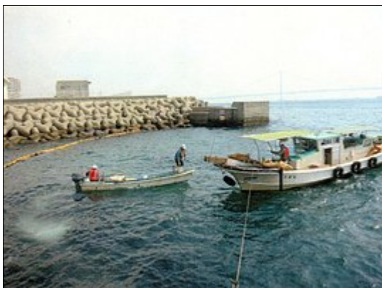
オイルフェンスによる回収油の移送
