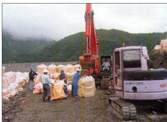
大型土嚢による通路の確保
