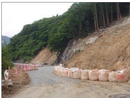
矢びつダム付近の道路復旧
