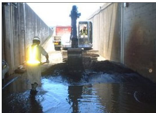
トンネル内泥土の撤去
