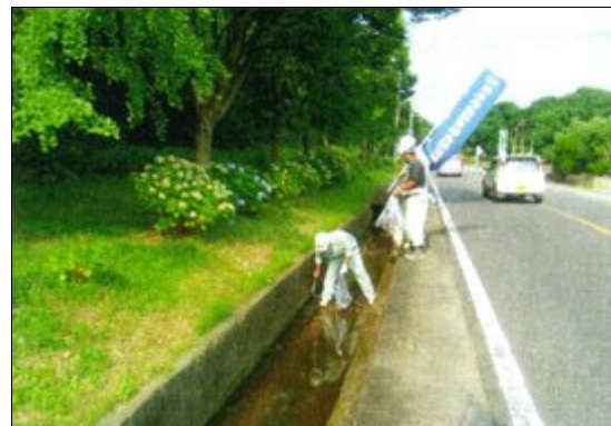
道路側溝の清掃
