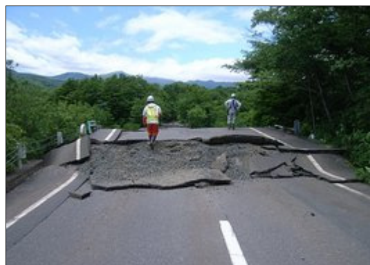
祭時（まつるべ）大橋付近の道路被害
