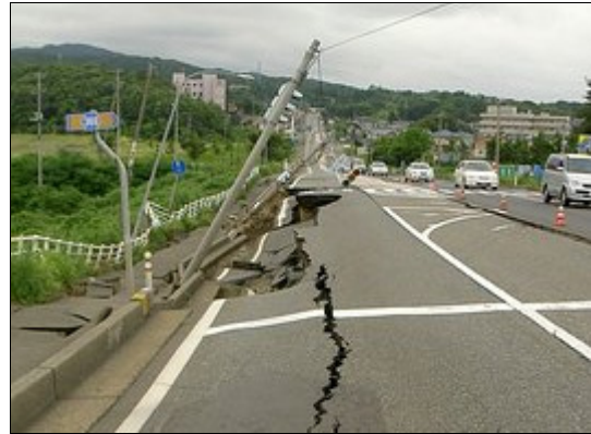
新潟県中越沖地震による道路被害
