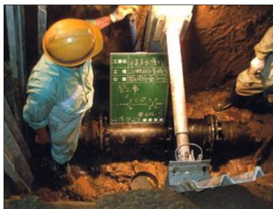
上水道の応急復旧
