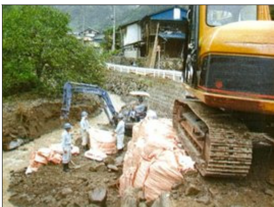
道路の応急復旧作業（南牧村）
