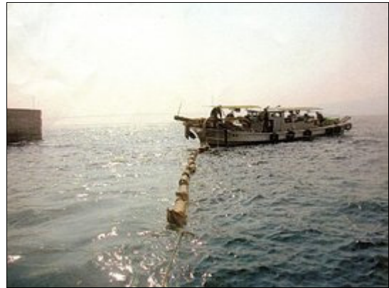
オイルフェンス設置
