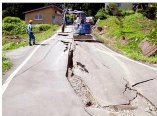
新潟県中越沖地震による道路被害
