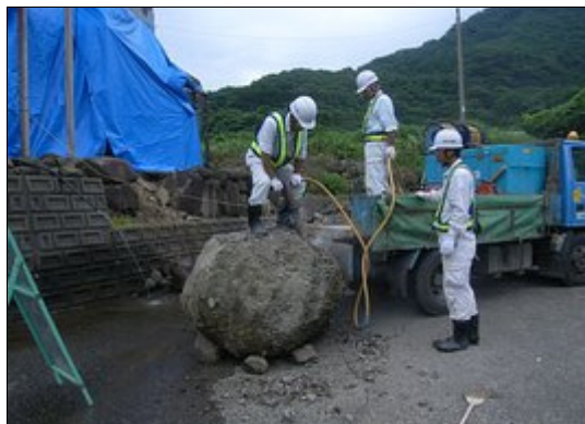
崩落石の撤去
