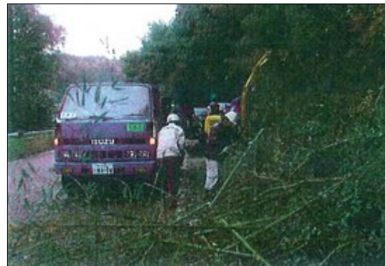
道路上の倒木伐採
