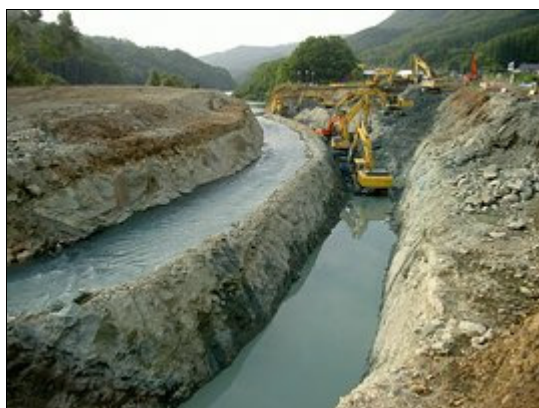
磐井川「せき止め湖」仮排水路建設工事
