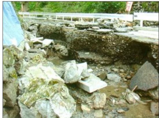
道路の崩壊（南牧村）
