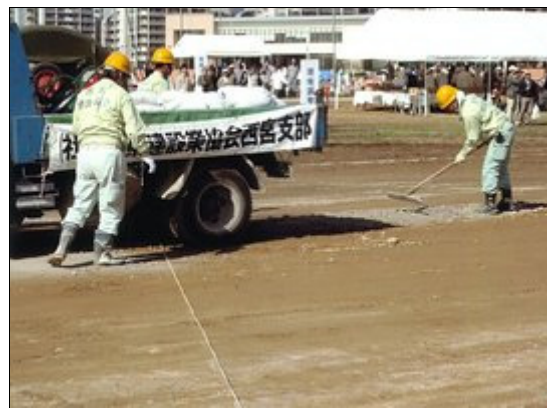
陥没箇所の応急復旧
