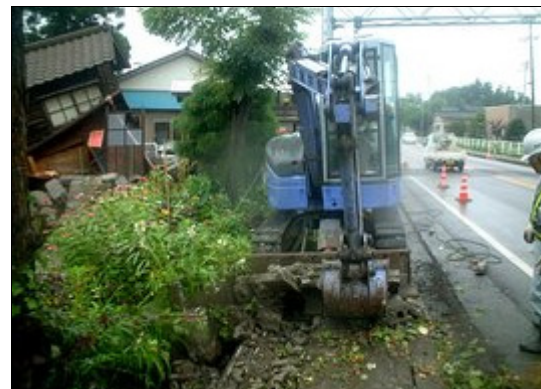
倒れたブロック塀の撤去
