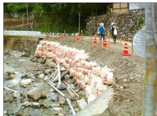
法面の応急修復（南牧村）
