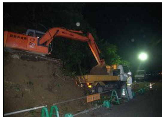
崩落土砂の撤去
