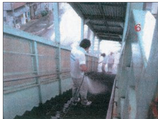
歩道橋の清掃
