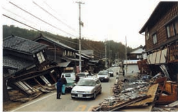
熊鷹の森の被害状況
