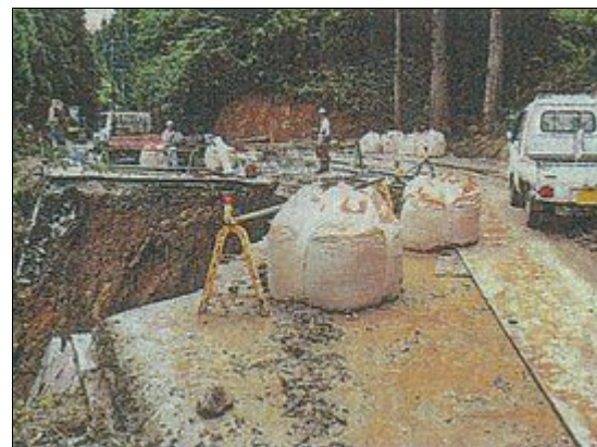
寸断された道路の応急復旧工事
