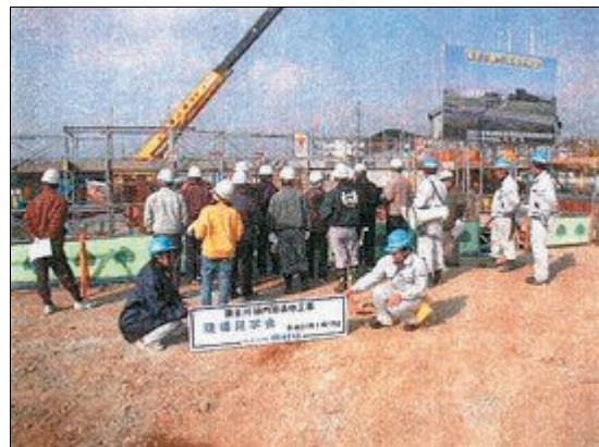
粟生川樋門築造工事現場見学会
