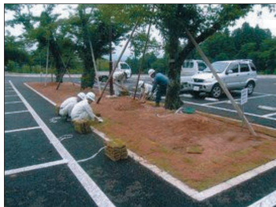
植樹帯の芝張り
