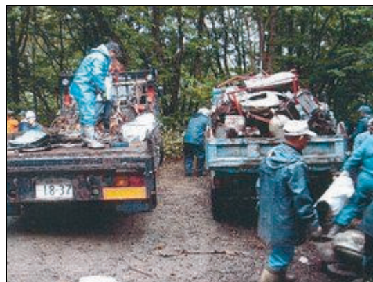
ユニック車とダンプへの積み込み
