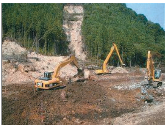
崩落土砂の撤去作業
