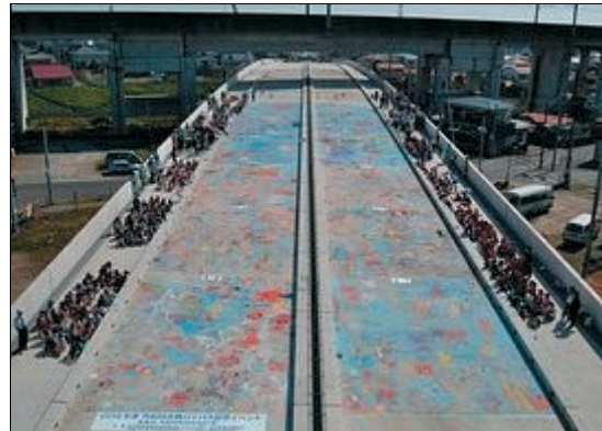
跨線橋に現れた水族館
