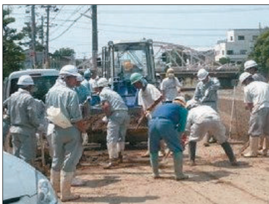
路面の土砂撤去
