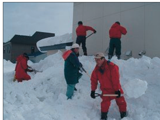
屋根からの落雪処理
