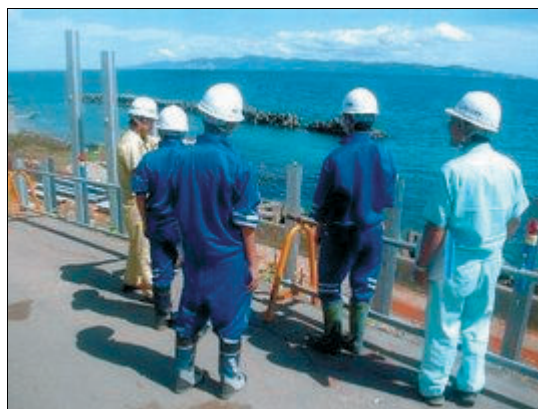
道路の凍雪害防止工事の学習
