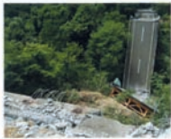
西子・田代内陸地帯の崩壊状況
