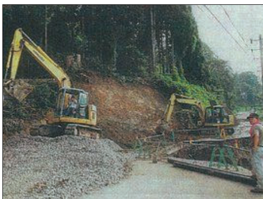
寸断された道路の応急復旧工事
