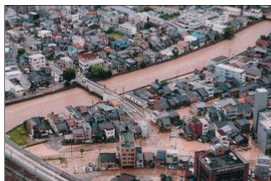
浅野川の氾濫による市街地浸水
