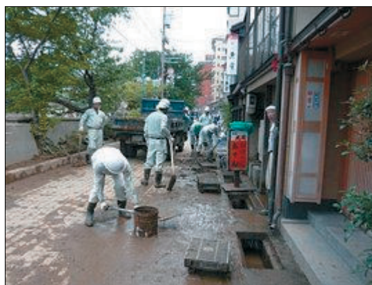
側溝の堆積土砂の撤去
