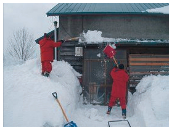
玄関先の雪庇落とし
