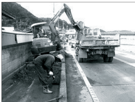
歩道の土砂撤去
