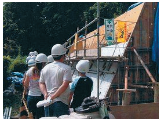
急傾斜地崩壊対策工事現場の見学
