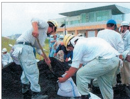
土のう袋への砂詰め
