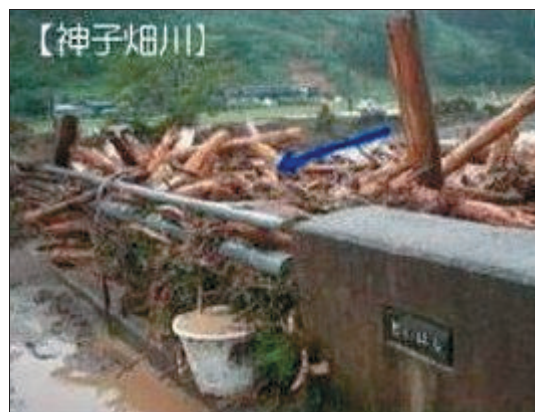
流木による橋梁部閉塞
