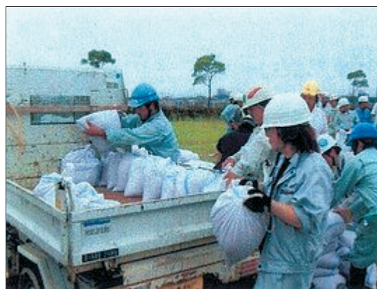
土のうの備蓄場への運搬
