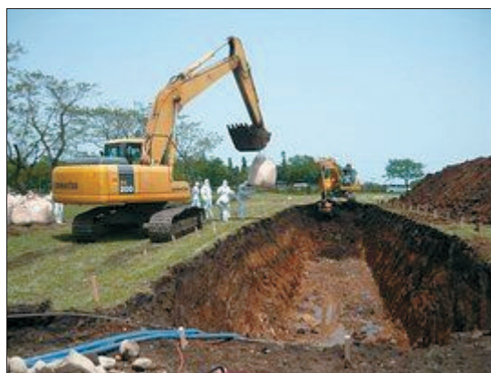
家畜の埋却穴の床掘り
