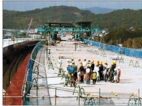
第二東名浜北高架橋工事現場の見学
