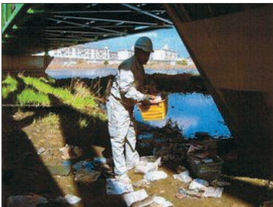
笹ヶ瀬橋下の投棄ゴミの回収
