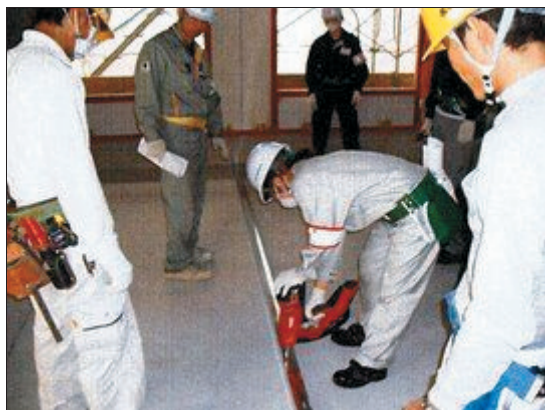
現場実習（内装工事）
