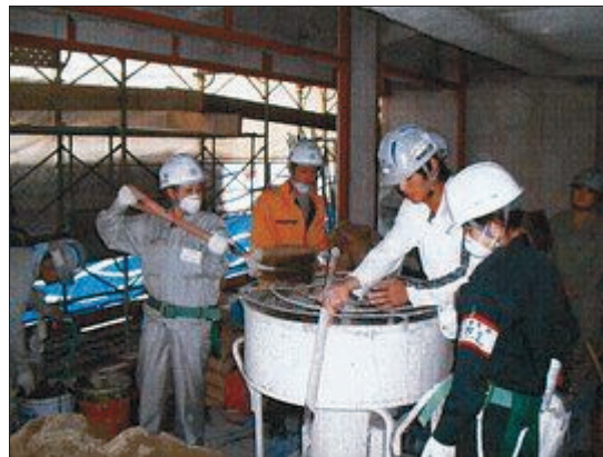
現場実習（左官工事）
