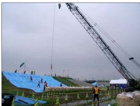
シート養生訓練（札幌会場）
