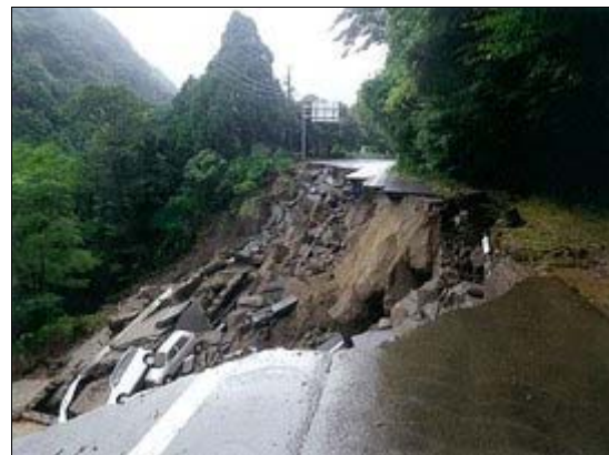
救出後崩壊した道路
