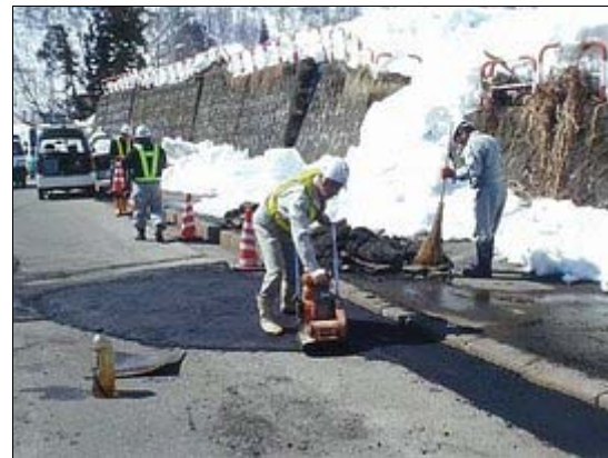
修復部の仕上げ
