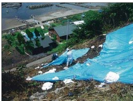
泊村の土砂崩壊面のシート養生
