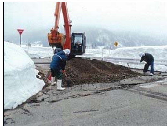
陥没箇所の穴埋め
