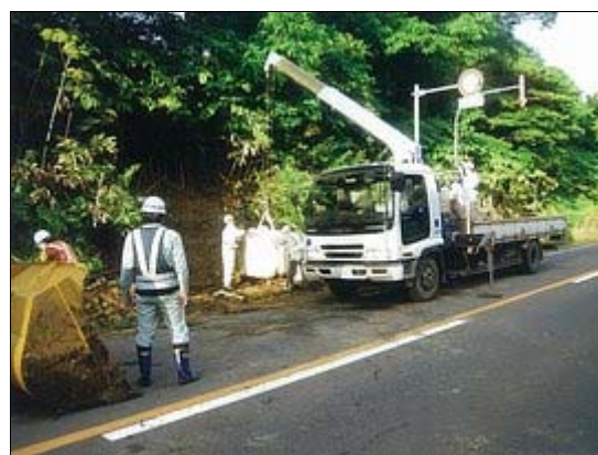
国道229号線の崩落土砂の撤去・搬出
