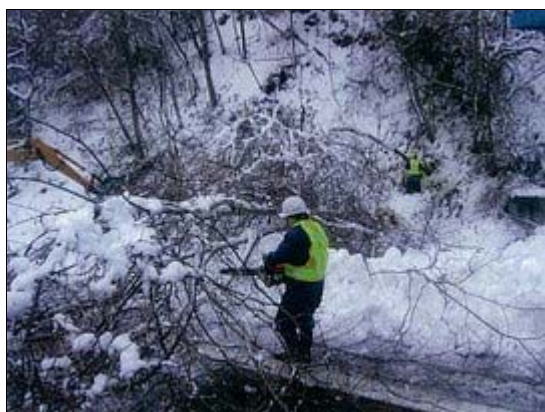
倒木の撤去作業
