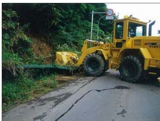
国道229号線の崩落土砂の撤去・搬出
