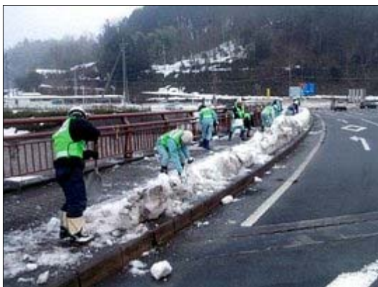
奥出雲大橋歩道の除雪作業
