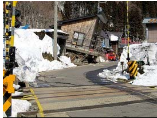
長野県北部地震による家屋被害
