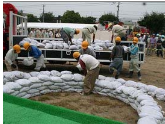
水防訓練（月の輪工法）
