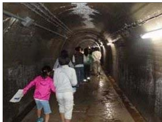
刈谷田川ダム内部の見学
