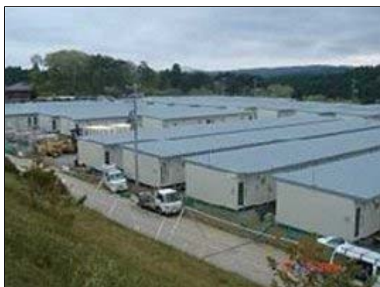
応急仮設住宅
