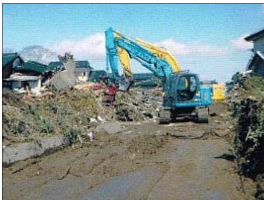
若林区井土地区の道路啓開
