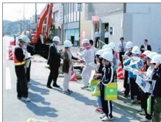
工事現場での説明
