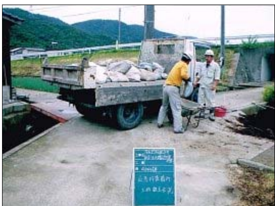
応急対策箇所土嚢撤去状況
