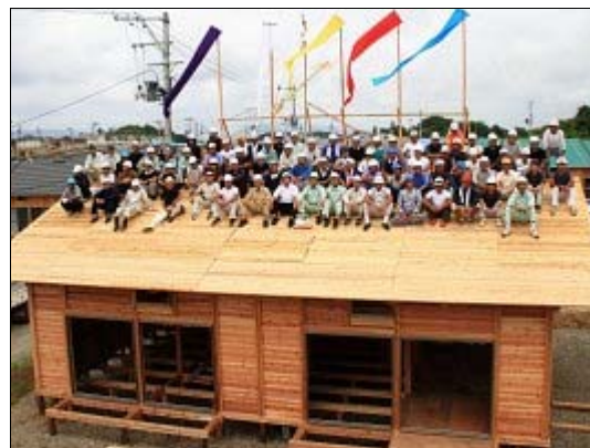
仮設住宅の上棟式
