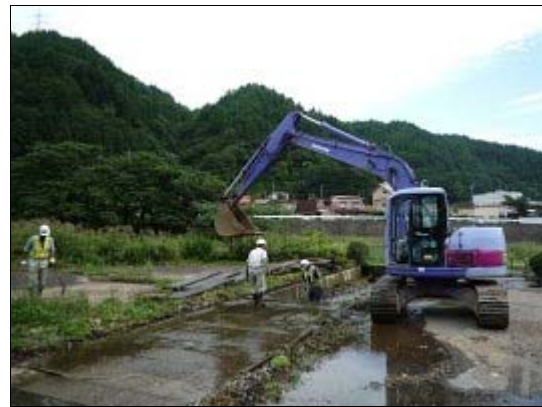
刈谷川の支流からの堆積土砂除去
