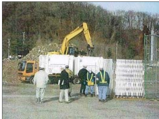
広域ガレキ処理の作業状況
