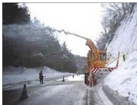
道路の除雪作業
