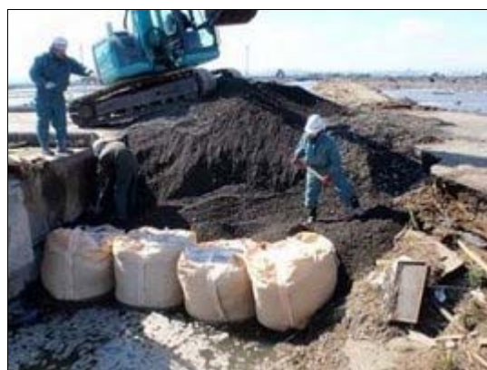
宮城県仙台市の道路橋の緊急復旧工事
