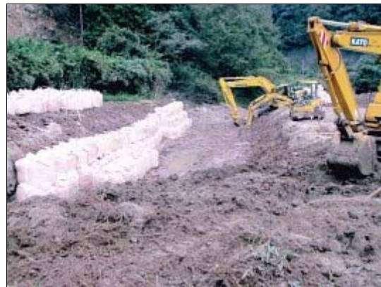
御嵩町の復旧現場
