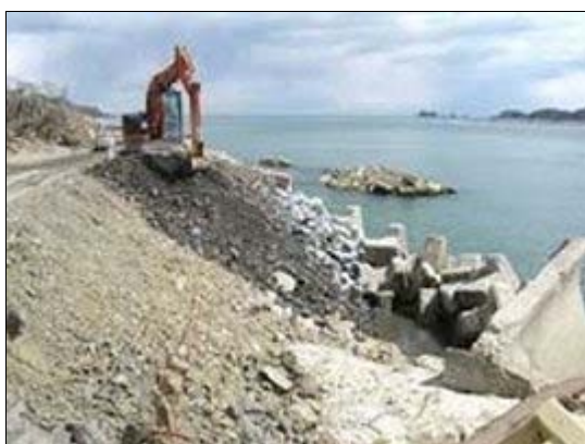
宮城県石巻市北上川の応急復旧工事
