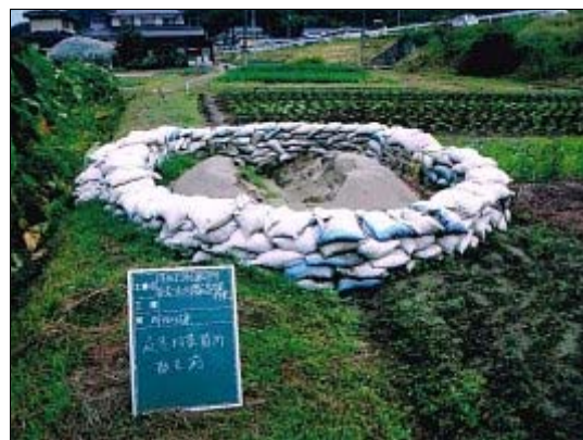
土砂流出防止土嚢積
