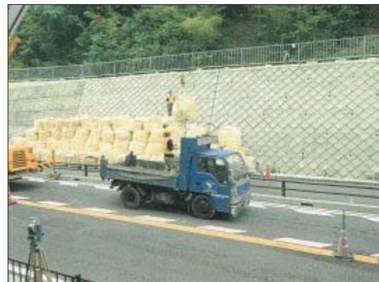
土嚢による応急復旧作業
