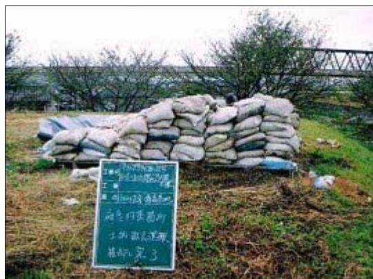
土嚢の仮置き
