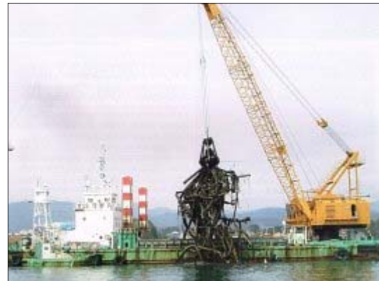
気仙沼港湾での啓開作業
