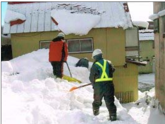
屋根の雪下ろし
