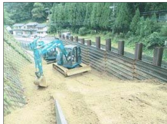
押え盛土工法による復旧工事
