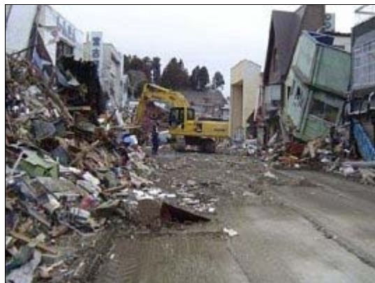
岩手県宮古市での道路啓開
