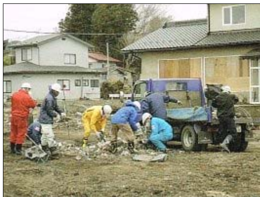
ボランティアの土砂撤収作業
