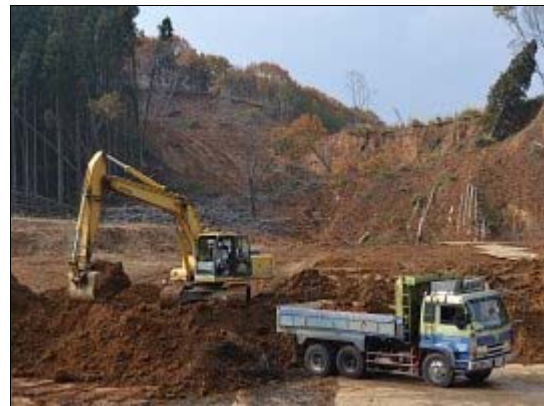
土砂倒壊の復旧現場
