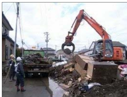
宮城県仙台市での民地のガレキ撤去作業
