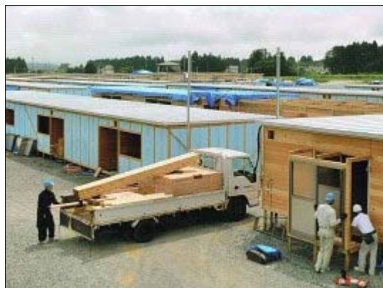
応急仮設住宅の建設
