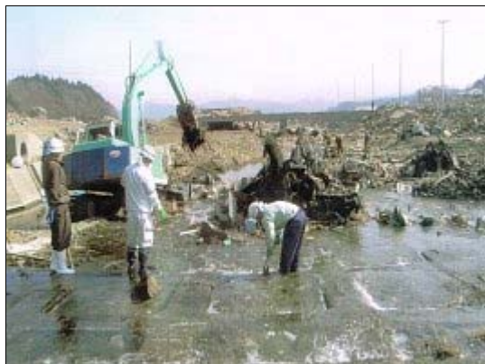
手作業での河川のがれき撤去
