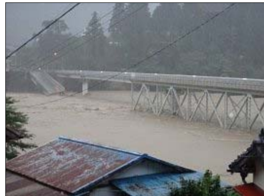
国道 168 号折立橋崩落
