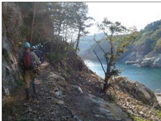
遊歩道の整備
