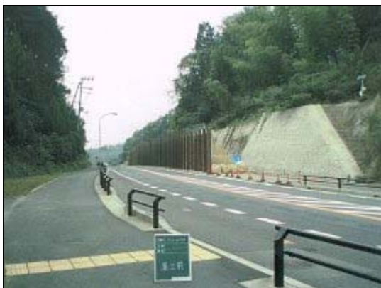
国道 9 号の復旧現場
