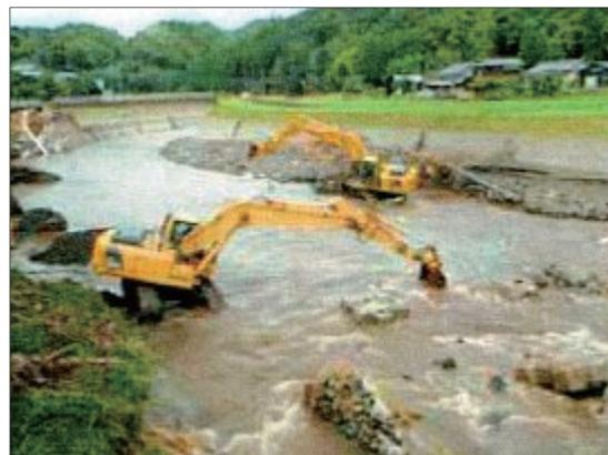
流路確保のための河床掘削
