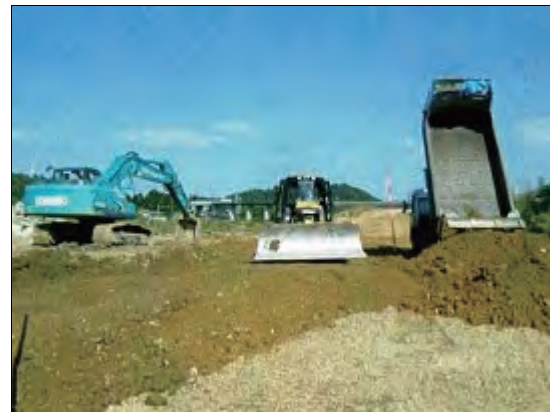
盛土の敷均し
