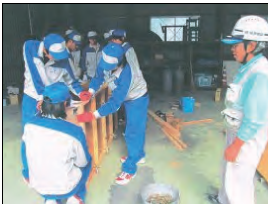
型枠製作実習
