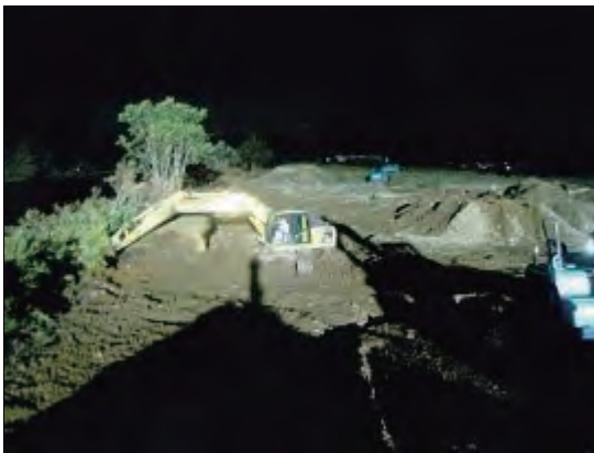
崩壊土砂の撤去
