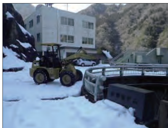
新豊根ダムでの除雪作業
