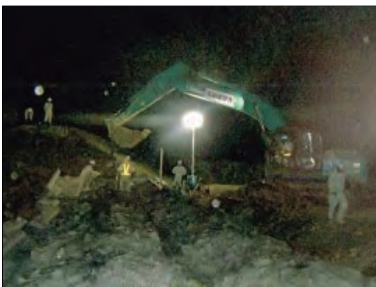
袋詰め玉石の積上げ
