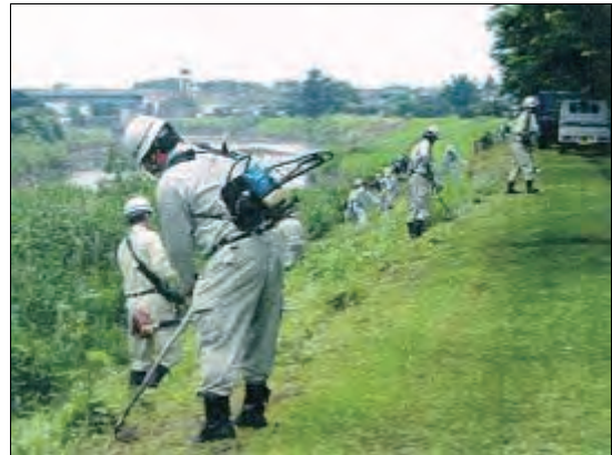
河川堤防の草刈り
