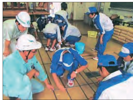
鉄筋加工・結束実習
