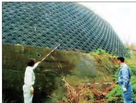
斜面保護ブロックの亀裂調査
