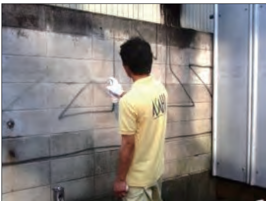
スプレーによるブロック塀の落書き消し
