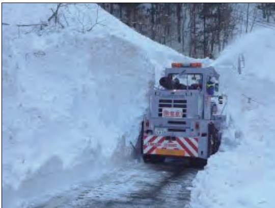
慎重に進む除雪車（山梨県早川町）
