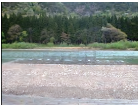
常浪川に設置する水上ステージ足場
