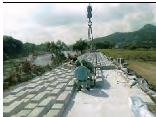
連節ブロックの設置
