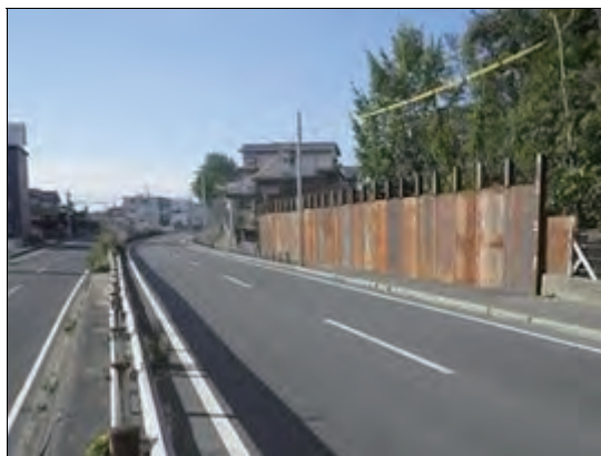
国道54号線の状況(復旧後)
