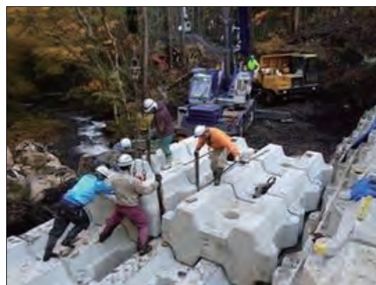
根固めブロックの設置 (木曾町)
