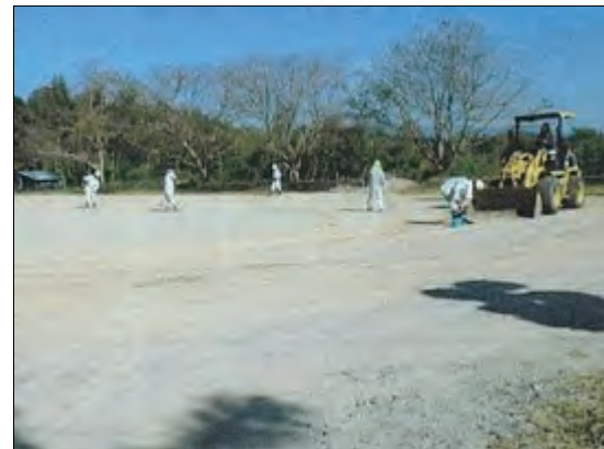
小石の除去（平成 25 年）
