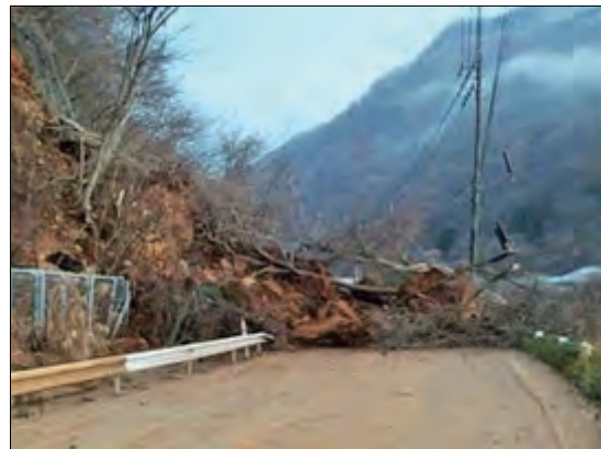
国道 148 号線の土砂崩壊（白馬村）
