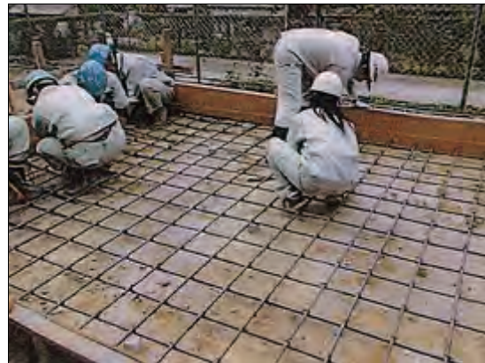
鉄筋組立て（第 2 回）
