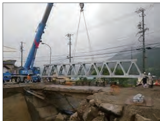
梨小沢仮橋の架設 (南木曾町)
