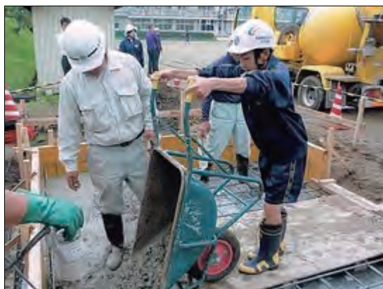
基礎コンクリート打設作業
