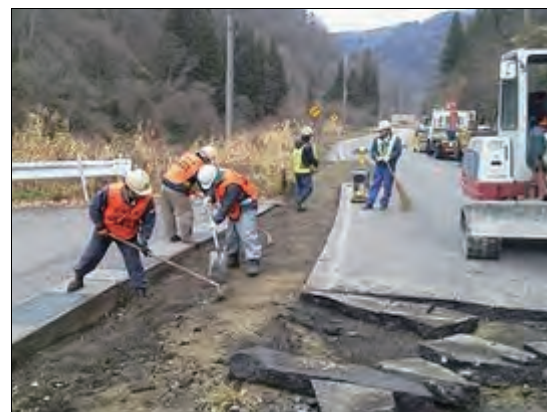
県道の舗装復旧
