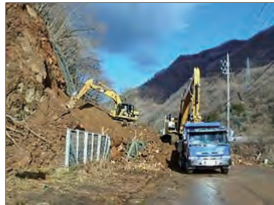
国道 148 号線の土砂撤去
