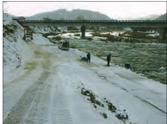
大日川（下野大橋下流右岸）
