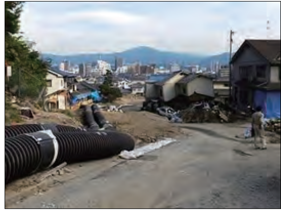
仮排水路の設置
