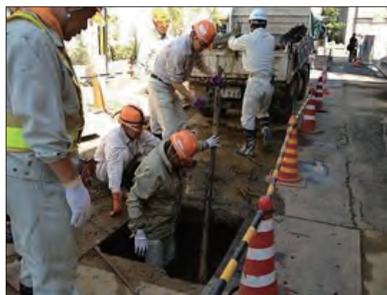
吾妻川下流暗渠部の土砂撤去
