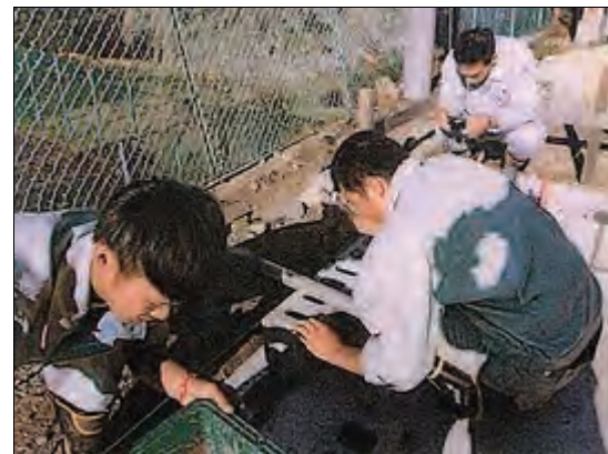
ブロック天端モルタル塗り（第 4 回）
