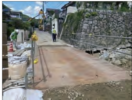
仮橋の設置（復旧後）
