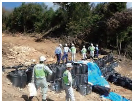
進入路確保のための現地調査
