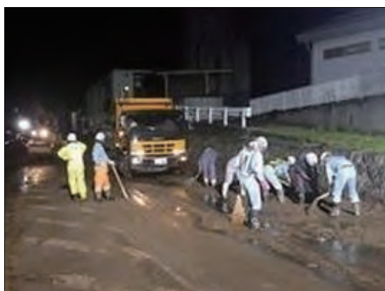
国道19号線の土砂搬出 (南木曾町)
