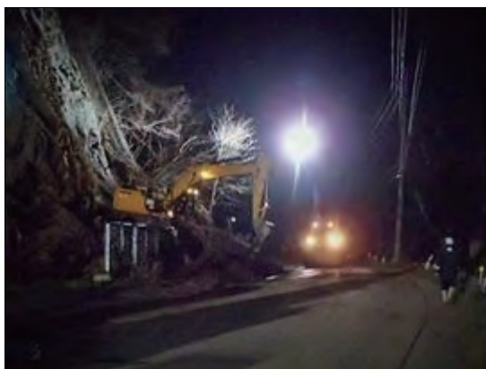
国道 148 号線の夜間作業
