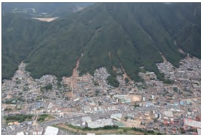
土石流・がけ崩れの発生 (提供 : 国土地理院)
