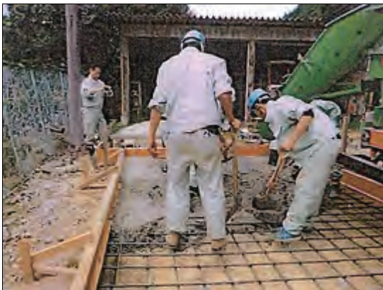
コンクリート打設（第 2 回）
