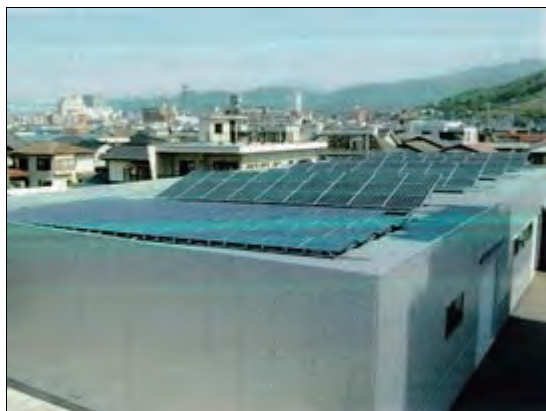
太陽光発電システムの設置
