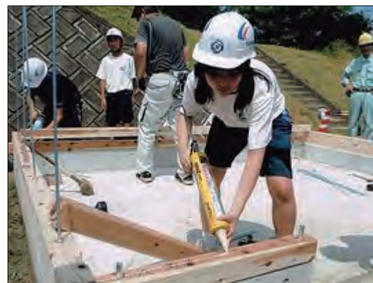
スタッキングハウスの木組み作業
