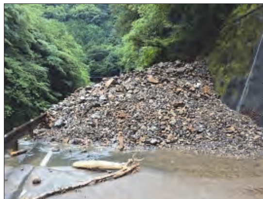
土砂に埋もれた県道 210 号線
