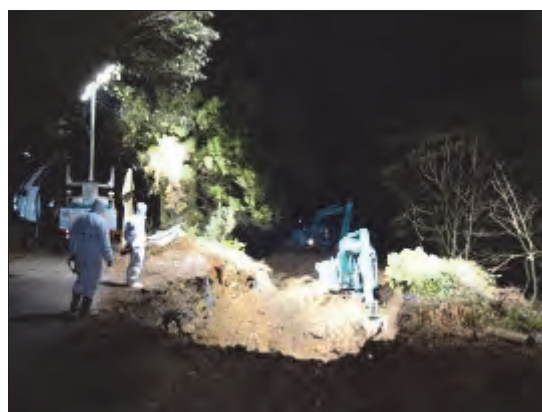
埋却溝の掘削
