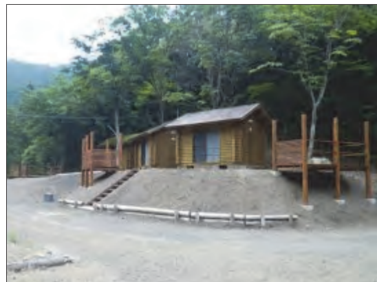
コテージのウッドデッキ設置
