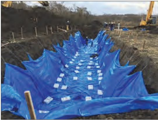
埋却溝のシート張り
