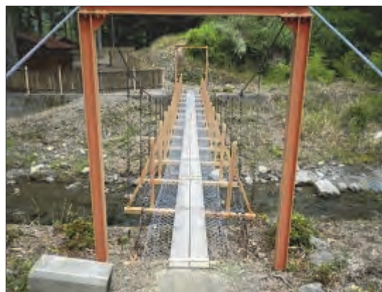
整備後の吊り橋
