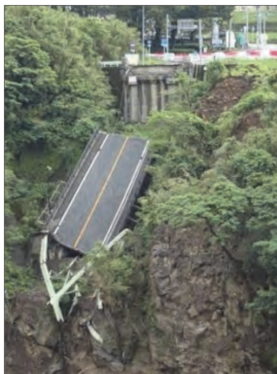
阿蘇大橋の落橋
