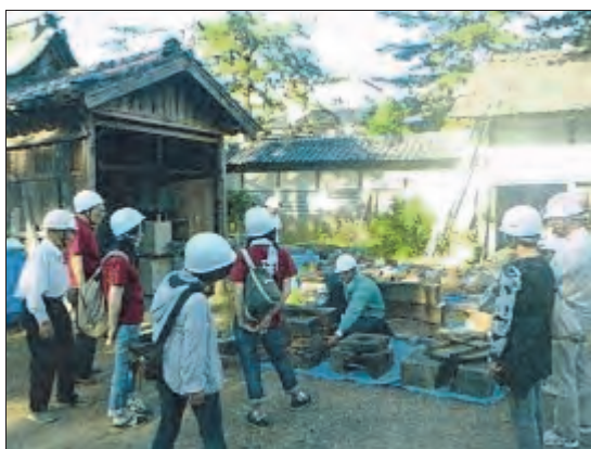
台所門の修復現場見学
