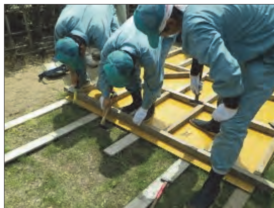
コンクリート平板型枠組立て
