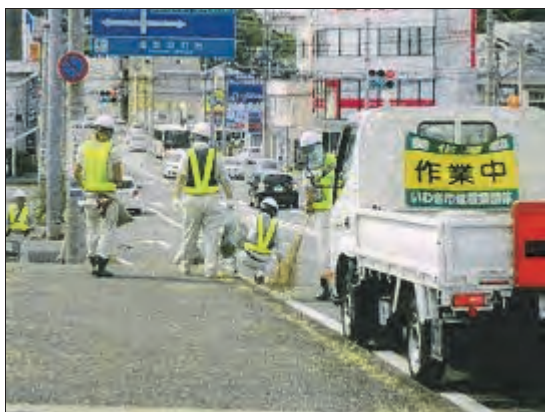
道路側溝の清掃
