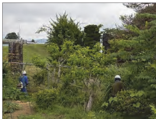
江尻第 3 排水機場の草刈り
