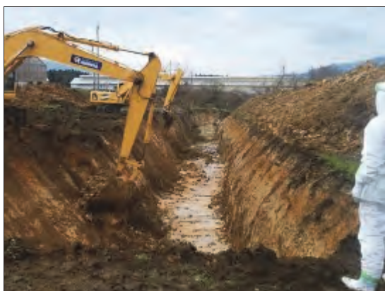
埋却溝の掘削
