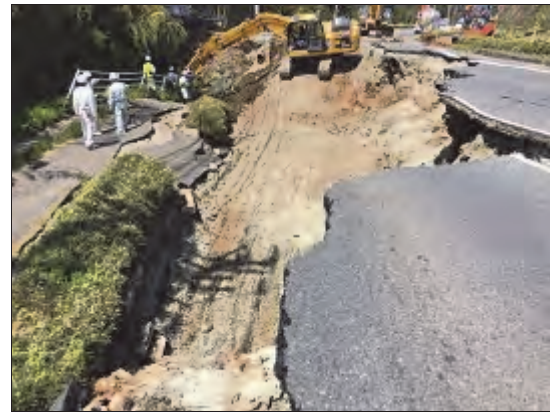
道路応急復旧（益城町）
