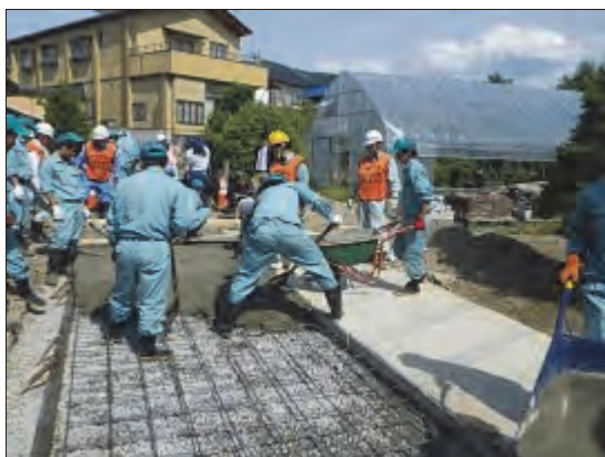
土間コンクリート打設
