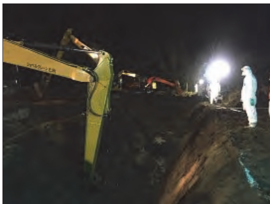
埋却溝の掘削
