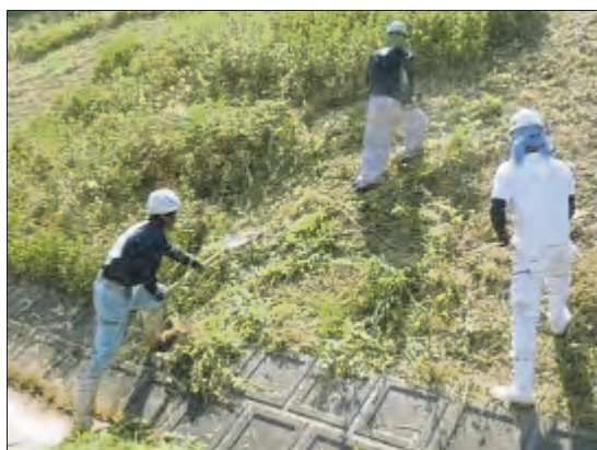
斜面の草木伐採
