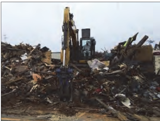
倒壊家屋の解体
