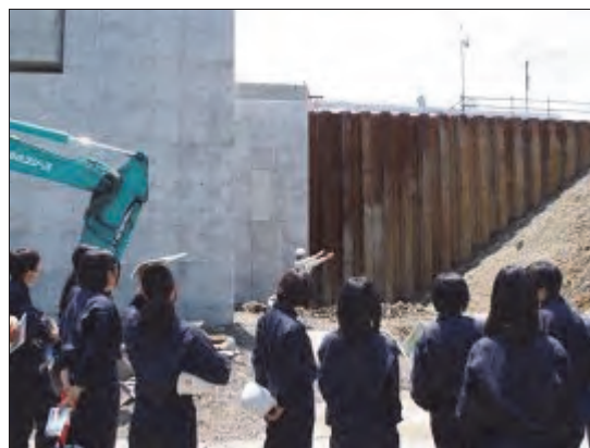
橋梁上部工の現場見学
