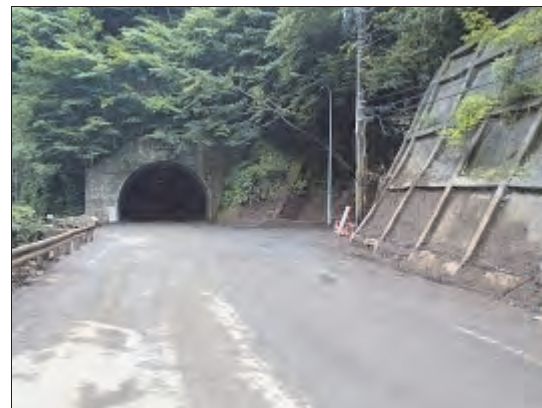
復旧作業完了
