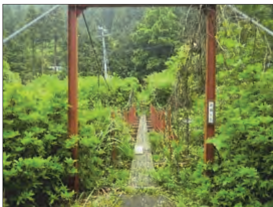
整備前の吊り橋
