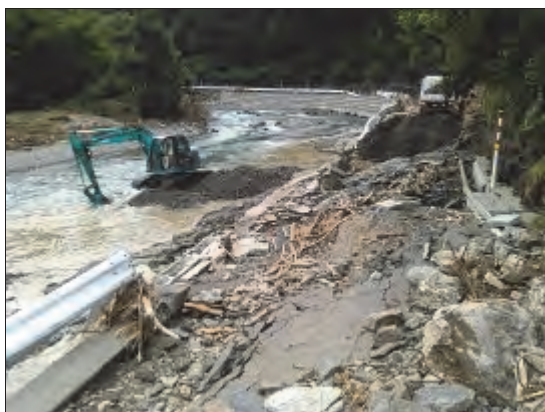
河川の土砂・流木撤去 (岩泉町)
