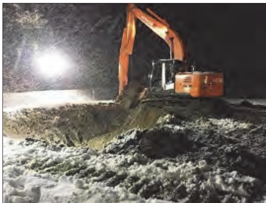
降雪の中での埋却溝の掘削
