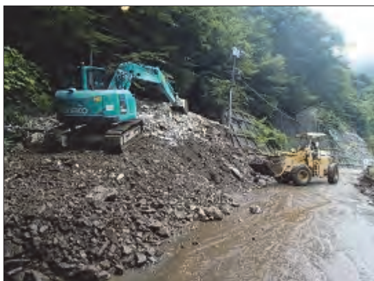
堆積土砂の撤去作業
