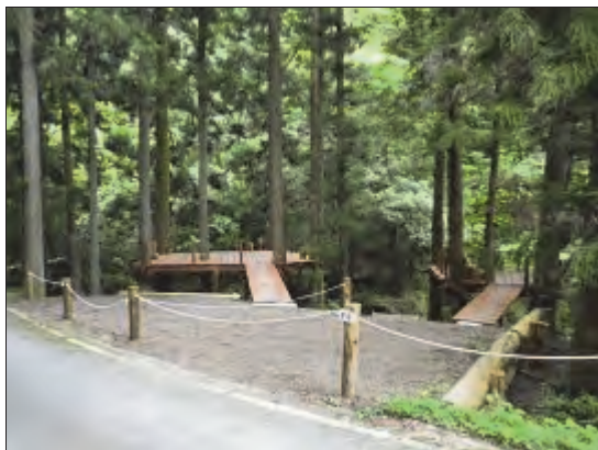
ウッドデッキサイトの増設
