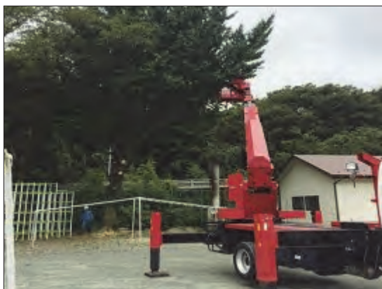
小学校の樹木伐採
