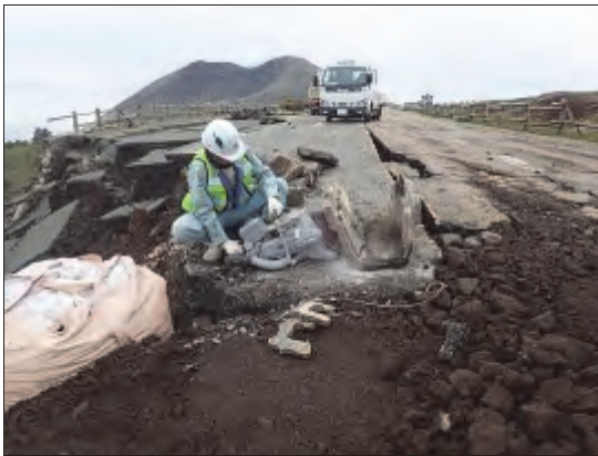
道路応急復旧（県道229号線）
