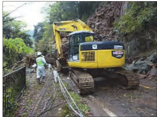
道路啓開（県道45号）
