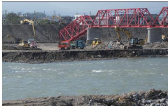
橋台が流され、橋桁が落下
