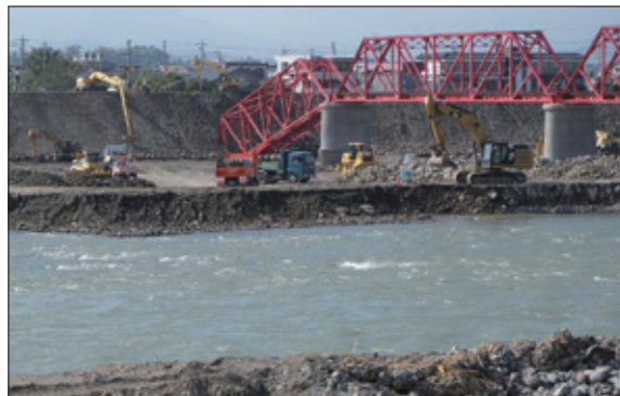
橋台が流され、橋桁が落下
