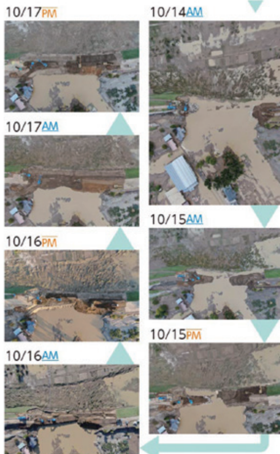
昼夜を問わない作業により仮堤防が早期復旧
