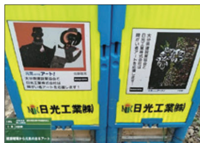
工事現場に設置される「元気のでるアート！」看板
