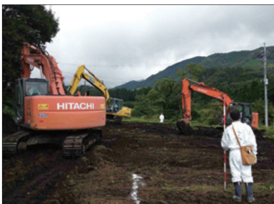
掘削準備作業等
