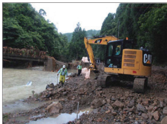
球磨田浦線（田浦町吉尾地区）応急復旧活動
