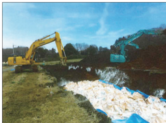
フレコンが収まり埋戻しを開始したところ
