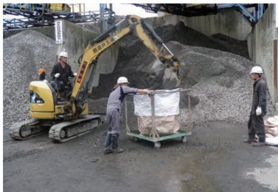
工場にて大型土嚢作製
