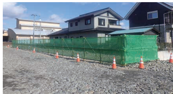
用地造成地周囲に設置した防塵ネット
