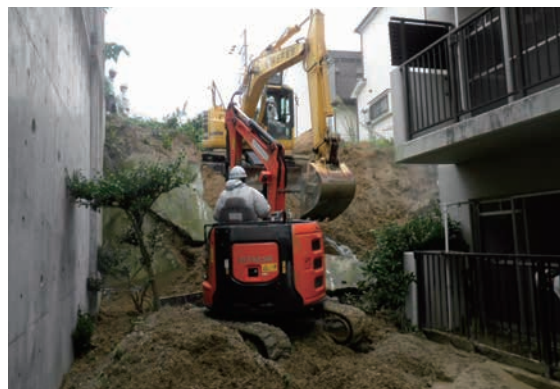
重機2台による土砂掻き出し
