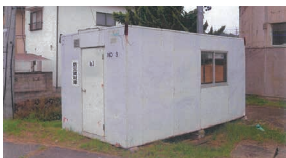
栗木組本社 防災資材備蓄倉庫
