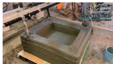
3D プリンタを活用した集水桝の製作の様子
