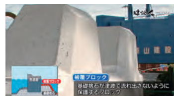
実際に現場で作られている被覆ブロック
