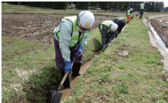
R 4 重要文化的景観地区内の「春季水路整備」
