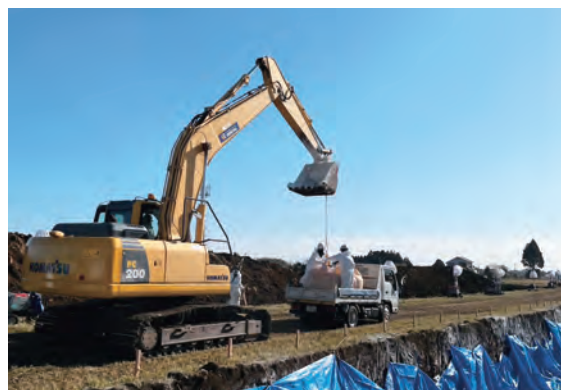
作業状況(川南町)
