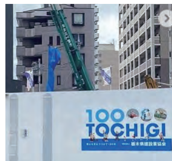
施工現場に設置しPR
