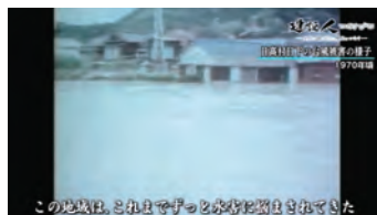
日下川浸水被害の様子
