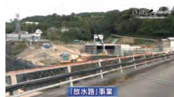
日下川放水路事業現場
