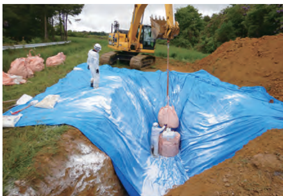
殺処分した鶏の埋却作業
