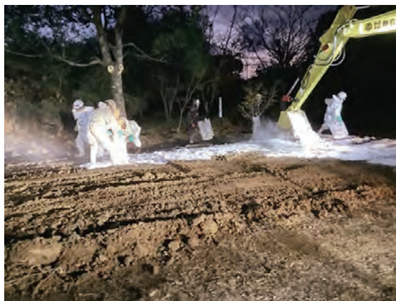
防護服等の埋却完了
