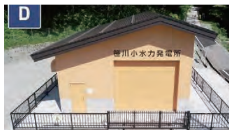
小水力発電所
