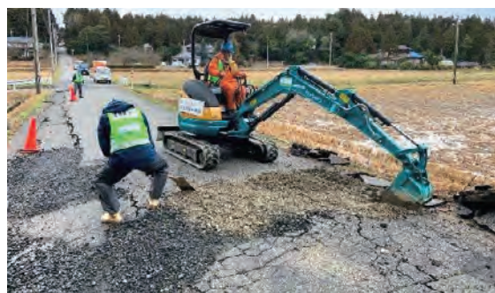
道路啓開作業(珠洲市)
