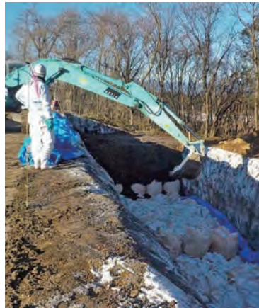
石灰散布状況
