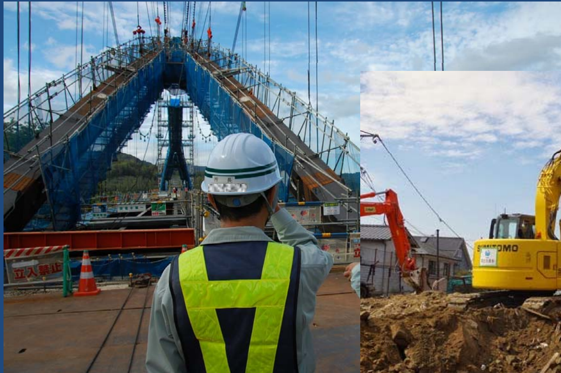
北海道 夕張シューパロダム湖横断橋建設工事
