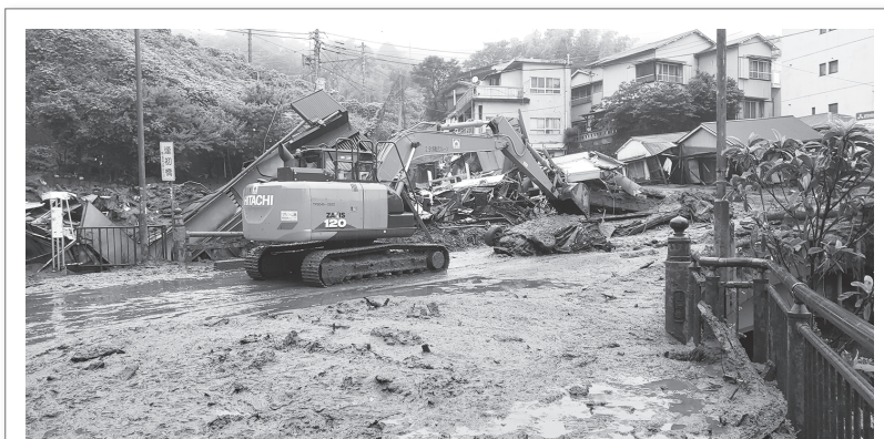
がれき撤去による復旧活動（静岡県建設業協会（三島建設業協会））
