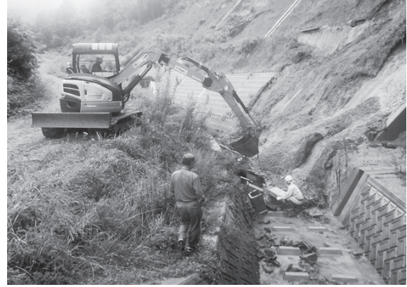
令和3年8月豪雨 南部町の大谷川流路部の土砂崩落による 撤去作業(鳥取県建設業協会)
