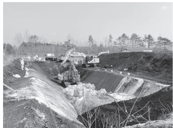
鳥インフルエンザの埋却作業(岩手県建設業協会)
