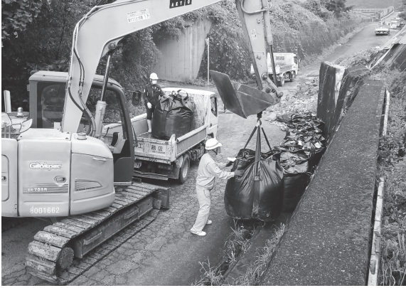
令和3年8月豪雨 佐賀県内での道路応急復旧作業 (佐賀県建設業協会)
