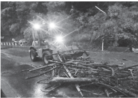
令和3年8月豪雨 浜坂町内の流出土砂および 倒木撤去作業(兵庫県建設業協会)
