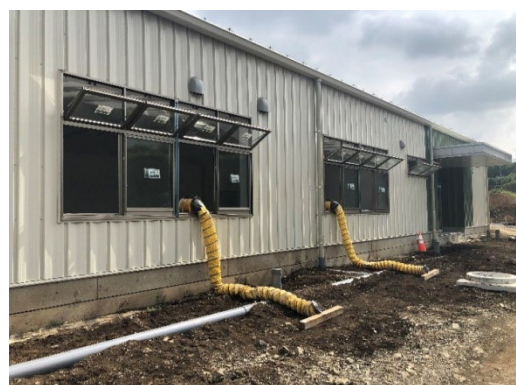
【写真②】送風機による換気(室外側)
