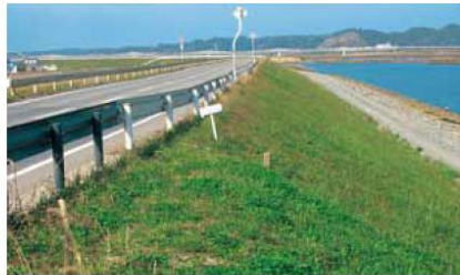
鳴瀬川右岸の河口付近は耐震化されていたため大きな損傷もなく、堤防が避難路としての役割も果たすことを実証した。(11年10月)
