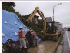
国道4号土砂流出撤去等作業の様子 写真：(一社)宮城県建設業協会 提供
