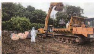
連日交代制で実施した掘削・運搬・埋却作業 写真：栃木県提供
