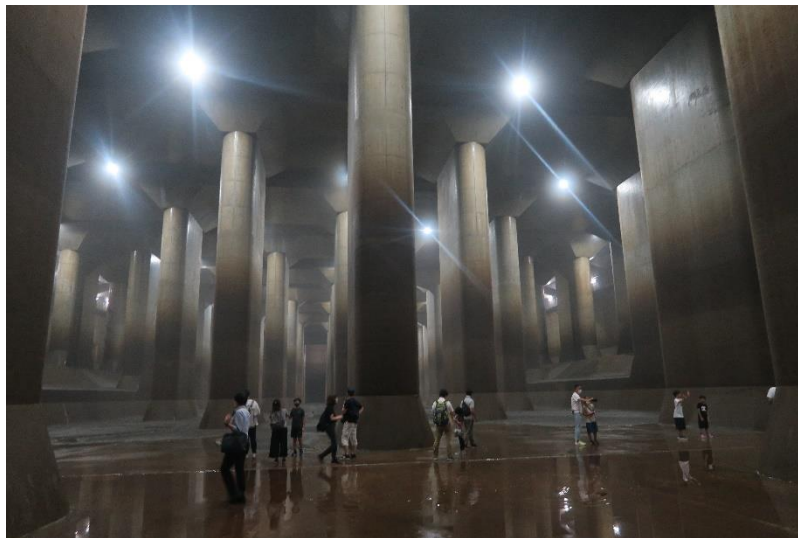
首都圏外郭放水路見学ツアー（東京建設業協会）
