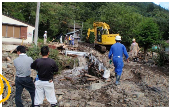
【復旧作業状況】
