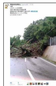
H27.9.9投稿 桐生市黒保根村 沼田大間々 線 台風18号による土砂崩れ
