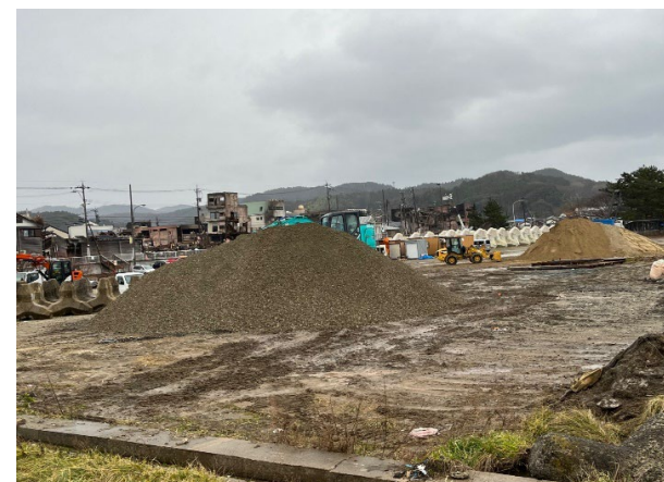
○輪島市輪島港 碎石運搬
