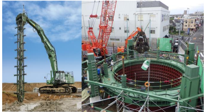
パワーブレンダー工法・アーバンリング工法
