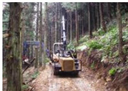
森林作業道整備
