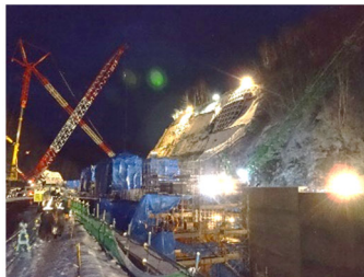
例2: 工事照明のLED化
