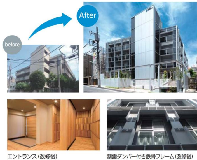
エントランス(改修後)
