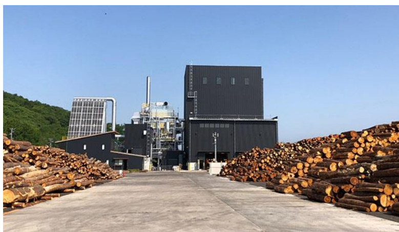
木質バイオマス発電所
