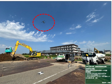
(ICT建機による崩落斜面の土砂撤去)
