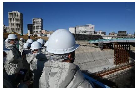
③ 建設工事見学会
