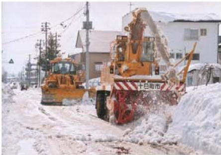
写真-3 除雪機械による作業風景
